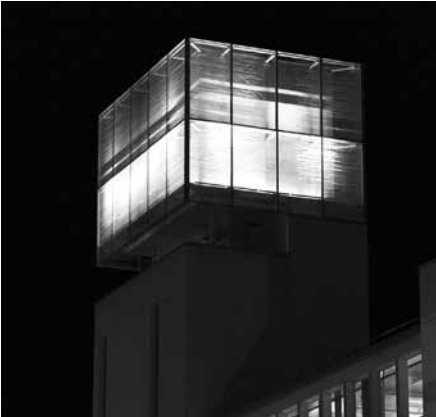
Nach Sonnenuntergang strahlen die 36 aufwändig keramisch bedruckten Lamine an der hinterleuchteten Fassade wie ein Leuchtturm in die Ferne.
