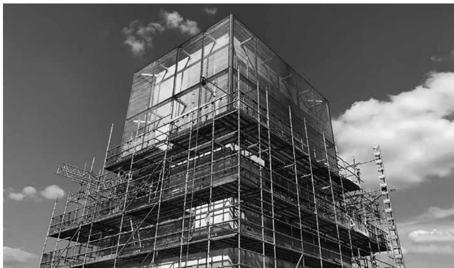
Das Glaskunstwerk „In Other Words“ thront am Zentralturm des Cambridge Assessment, hier noch im Bau.
