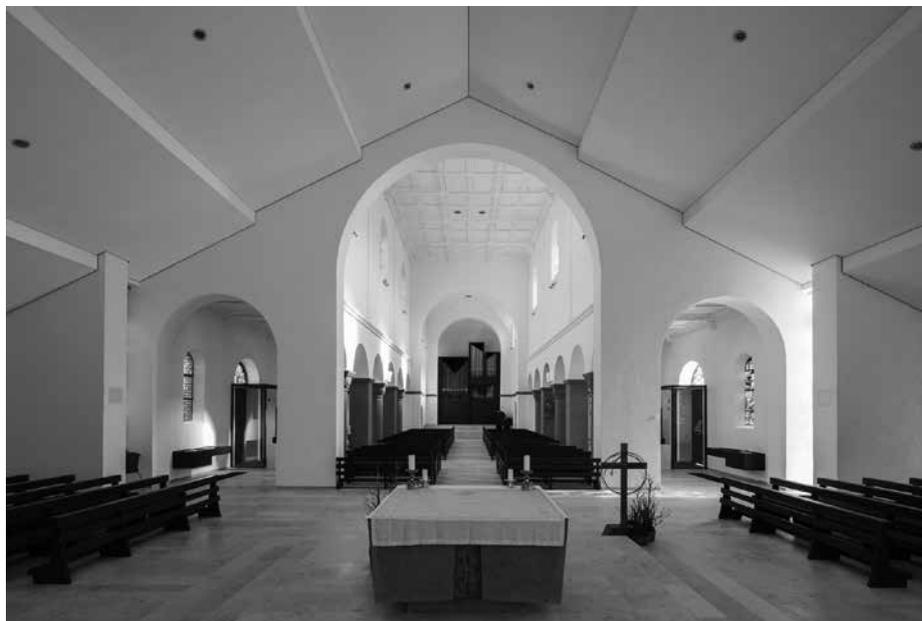
*Die Holzdecke im Anbau wick einer modernen Akustikdecke. Die Oberfläche der fugenlosen Decke besteht aus der feinkörnigen Deckbeschichtung StoSilent Decor M, die notwendigen Bewegungsfugen der Boards aus Blähglasgranulat befinden sich nicht sichtbar in den Treppungen.*
