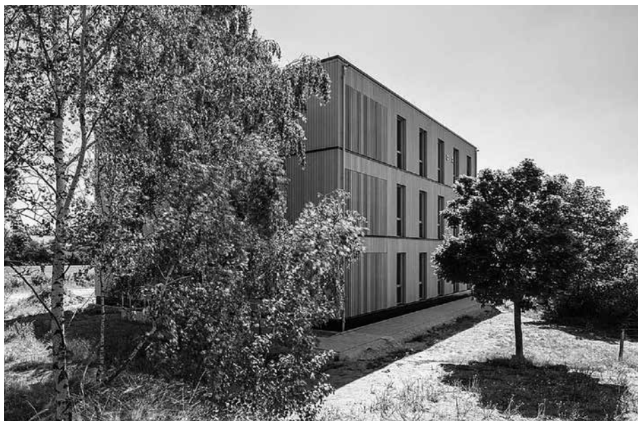
Preisgekrönt: die Holz-Erweiterungsbauten am Lessinggymnasium und am Gymnasium Neue Oberschule.
