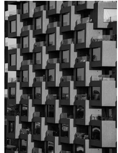
„Qualitativ hochwertige Betonfertigteilelemente fügen sich geschickt zu individuellen Loggien“
