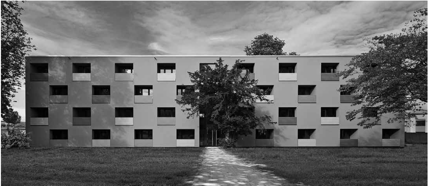
Preisträger: Der Neubau der stationären Wohnungslosenhilfe der Diakonie, Münchenstraße 11a.
