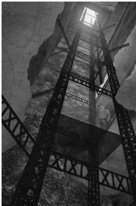
Entwurfssprinzip am Großen Bunkerberg: HINEINBOHREN.
