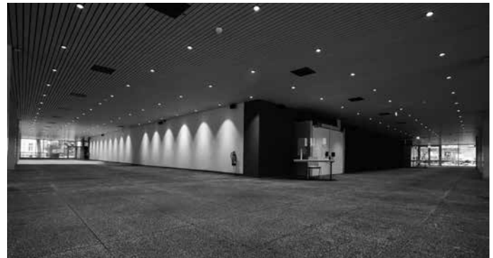
Die neue nichtbrennbare Leistendecke des Foyers sorgt für einen helleren Raumeindruck. Die über 300 leuchtstärkeren LED-Punktleuchten in der Decke konnten im ursprünglichen Raster wieder eingebaut werden.
