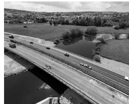
Ultraschallmessungen an einer Brücke. Als „digitaler Zwilling“ in Zukunft für BIM gespeichert.
