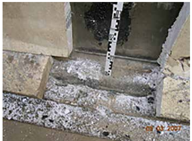
Abb. 9: nicht gerissene Abdichtungsbahn
