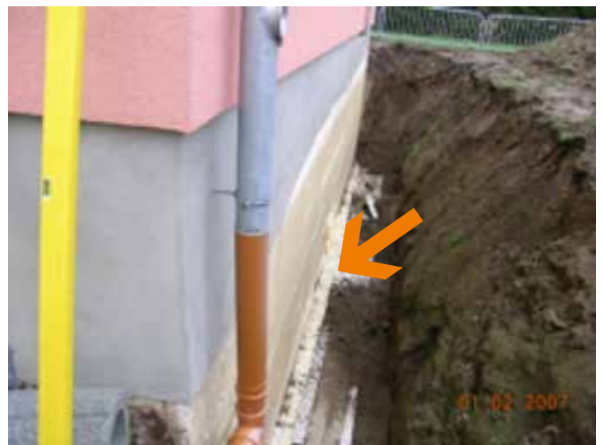
Abb. 8: verschobene Kellerwand
