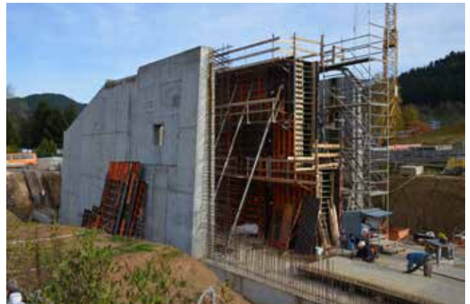
Zum Erstellen des gesamten Auslassbauwerkes mit einer angegebenen Länge von 39,50 m waren 360 m 2 LOGO.3 eingeplant. Foto: PASCHAL
