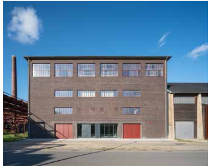
Die denkmalgeschützte Salzfabrik auf dem Gelände der Zeche Zollverein wurde energetisch saniert. © Thomas Eicken/Stiftung Zollverein
