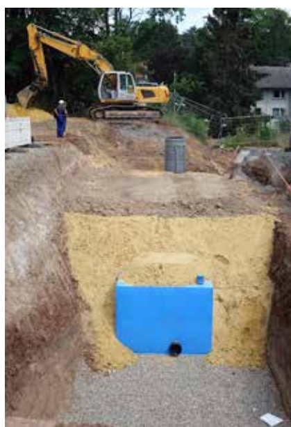
In einer zweiten kleineren Regenrückhalteanlage wurden zwei KS-Bluebox®-Elemente hintereinandergeschaltet. Foto: Funke Kunststoffe
