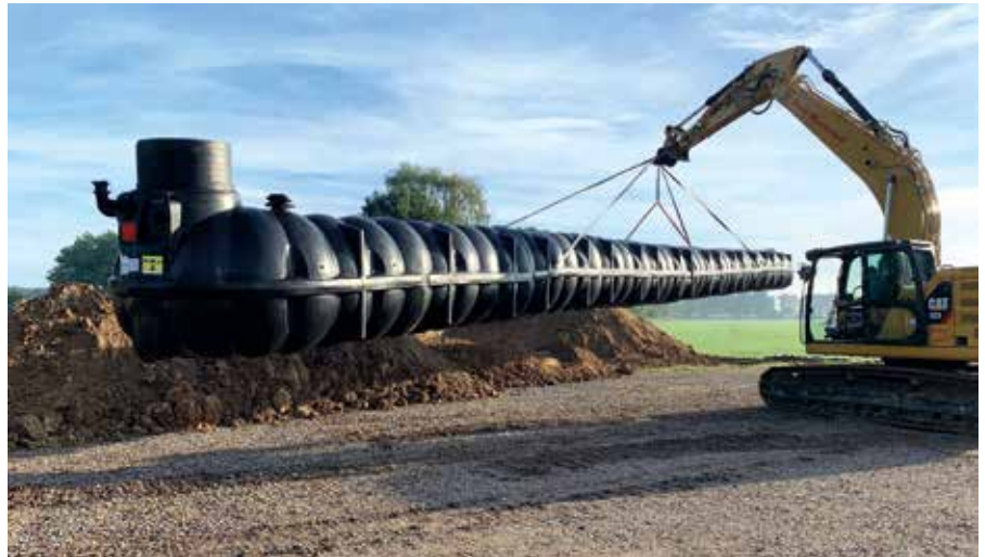
Um den Bauaufwand stark zu reduzieren, bieten sich die großvolumigen PE-Flachtanks NEOplus an. Sie benötigen eine wesentlich flachere Baugrube als herkömmliche Tanks.
