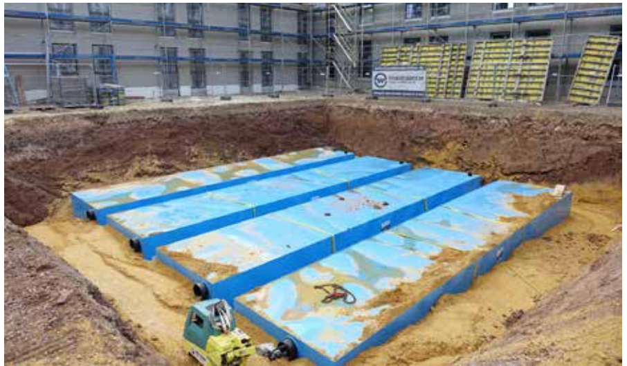
Auf dem Gelände der neuen Agentur für Arbeit in der Lewinskistraße in Kassel wird das Niederschlagswasser zukünftig gesammelt und gedrosselt abgeleitet. Die vier miteinander verbundenen KS-Bluebox®-Elemente von Funke haben jeweils ein Fassungsvermögen von rund 50.000 Litern. Foto: Funke Kunststoffe
