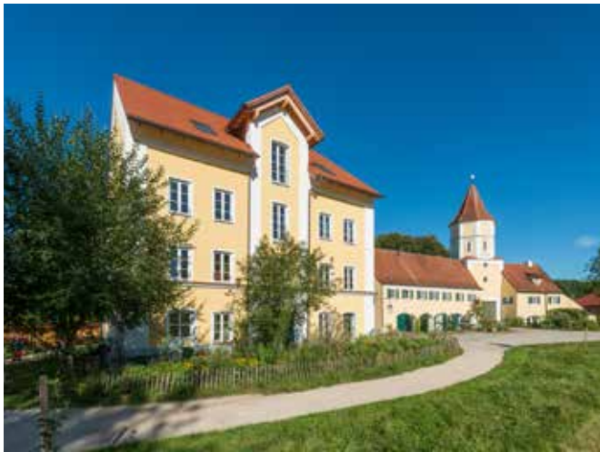
Mit einer innenliegenden Dämmung mit Poroton-WDF konnten die Auflagen des Denkmalschutzes eingehalten und die ursprüngliche Bausubstanz erhalten werden. Nach bereits einem Jahr umfassender Sanierungsarbeiten zogen die ersten Familien ein.
