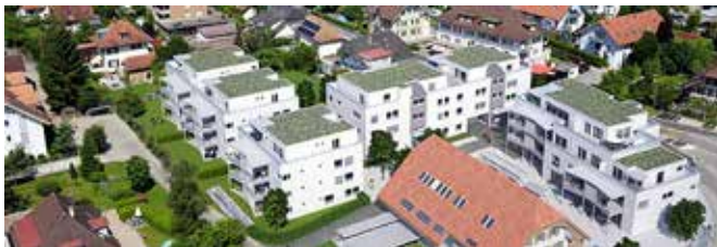
Projekt Bonacasa-Wohnungen in Utzenstorf.
