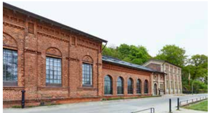
Ensemble Waterworks: Elbseite mit denkmalgeschützten Fensterfronten (Ausschnitt). Fotos: Hager Vertriebsgesellschaft mbH & Co. KG/Jochen Stüber
