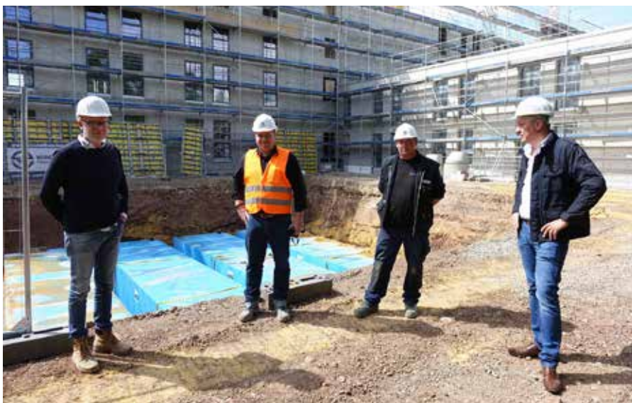
Baubesprechung vor Ort: Planer Arved Langewitz von AD. engineering, Projektleiter Marco Blix und Polier Oliver Meier von der ausführenden Wimmelbücker Tiefbau GmbH sowie Funke-Fachberater Dipl.-Ing. Martin Ritting (v. l.). Foto: Funke Kunststoffe
