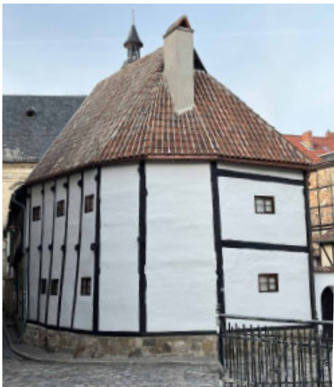
Das älteste Haus Quedlinburgs, eine Ständerbauweise, bei der die Deckenbalken in die durchgehenden Ständer eingezapft sind.
