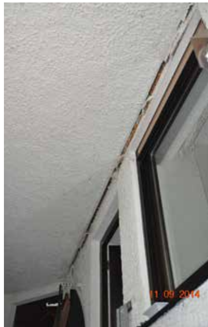
Abriss der Garagendecke vom Wohnhaus
