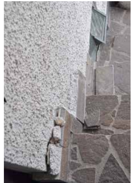
Abgelöste Sockelplatten
