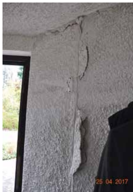
Trennfuge zwischen Wohnhaus und Garage
