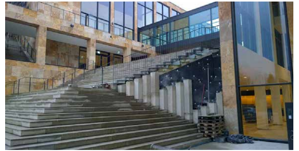
Öffentliche Durchwegung Kongresshallen - Treppenaufgang Friedrich-Ebert-Allee © Rolf Maaß
