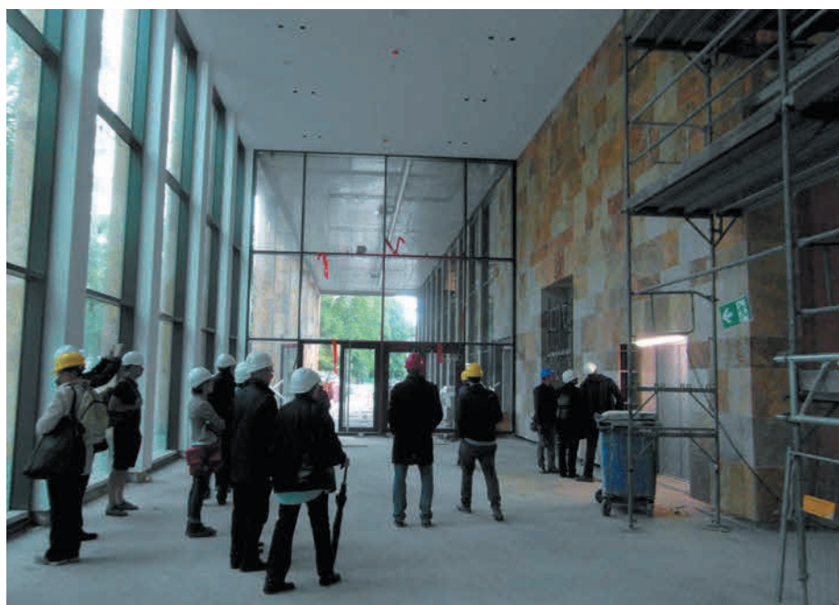
Tageslichtdurchflutetes Foyer der Halle 2 mit Öffnung zum Grünraum.
