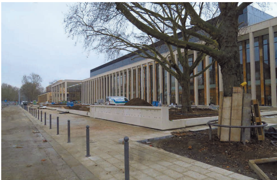
Außenbereich. Das RMCC Wiesbaden mit umgestaltetem Vorplatz an der Friedrich-Ebert-Allee - Ecke Rheinstraße. © Christian Bartha
