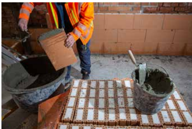
Zur Anbindung an beispielsweise Holzbalken oder Trennwände werden die Stoßfugen mit Mörtel versehen. Bild: Karsten Schöne/Raab Baugesellschaft
