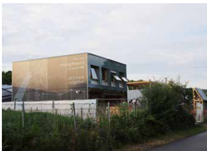
Ausstellungsgelände des Solar Decathlon Wuppertal 2022.
