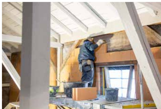
Im Gegensatz zu anderen Dämmsystemen wird die Poroton-WDF nicht an die bestehende Wand geklebt, sondern freistehend davor aufgemauert. Dadurch werden beispielsweise Probleme durch lose Putzstellen vermieden. Bild: Karsten Schöne/Raab Baugesellschaft
