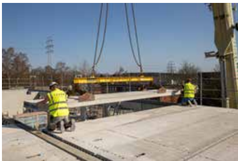
Deckenmontage bei den Klassenhäusern in der Schule Max-Eichholz-Ring, Hamburg: Mit vorgefertigten BRESPA®-Decken entfallen auf den Baustellen aufwändige Schal-, Bewehrungs- und Betonierarbeiten. Foto: Phillip Steiger
