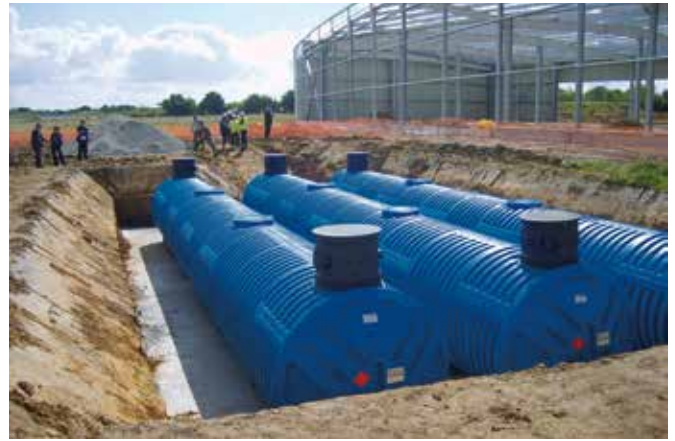
RIKUTEC Aqua'Terne 204 in der Montage für ein Großprojekt
