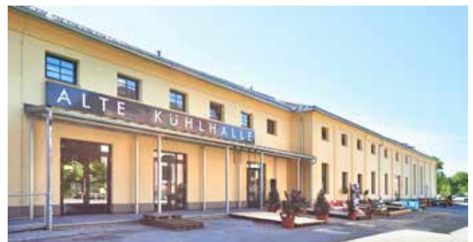
Die Sanierung der Anfang des 20. Jahrhunderts erbauten „Alten Kühlhalle“ des ehemaligen Coburger Schlachthofes ist seit Frühjahr 2022 abgeschlossen. Die Innovations- und Vernetzungsplattform „Creapolis“ der Hochschule Coburg mit ihren Werkstätten für Bürgerinnen und Bürger und der Verein „Zukunft.Coburg.Digital“ haben im Mai 2022 das Gebäude (Ansicht Westen) offiziell als Mieter übernommen.
