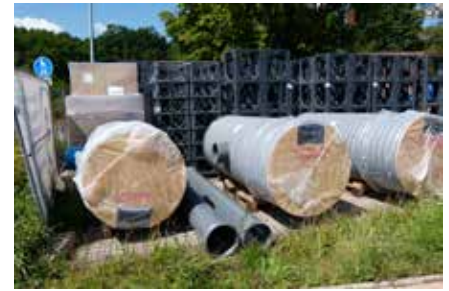
Regenwassermanagement als komplettes System: Neben blauen HS®-Kanalrohren und grauen geschlitzten Spülrohren wurden in Veitsbronn 648 D-Raintank 3000®-Elemente sowie zwei Reinigungsschächte und ein Drosselschacht eingebaut. Foto: Funke Kunststoffe GmbH
