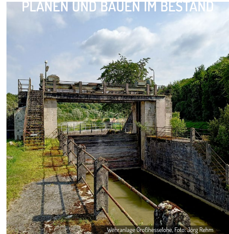
Wehranlage Großhesselohe, Foto: Jörg Rehm
