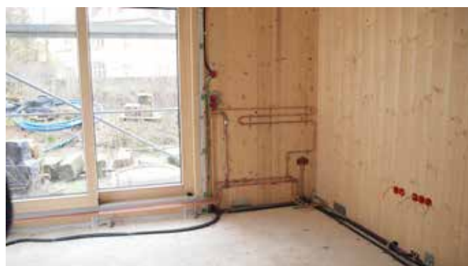
Massivholzwände, Wandtemperierung auf der Außenwand
