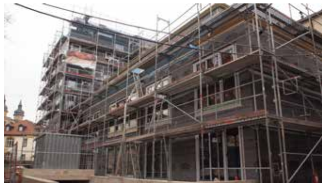
Wohngebäude in Vollholzbauweise
