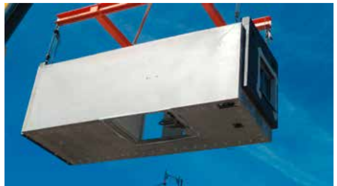
einzelnes Modul beim Versetzen
