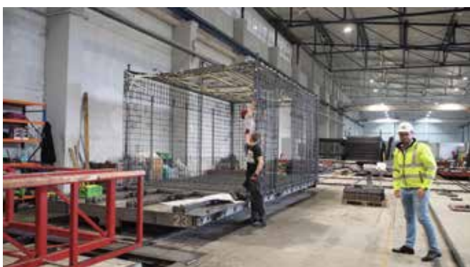
Fertigung der Bewehrungskörbe
