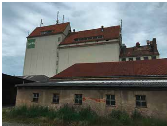
Bestandsfoto BaWa Silo von Juni 2016 – Stiefler + Seiler Architekten
