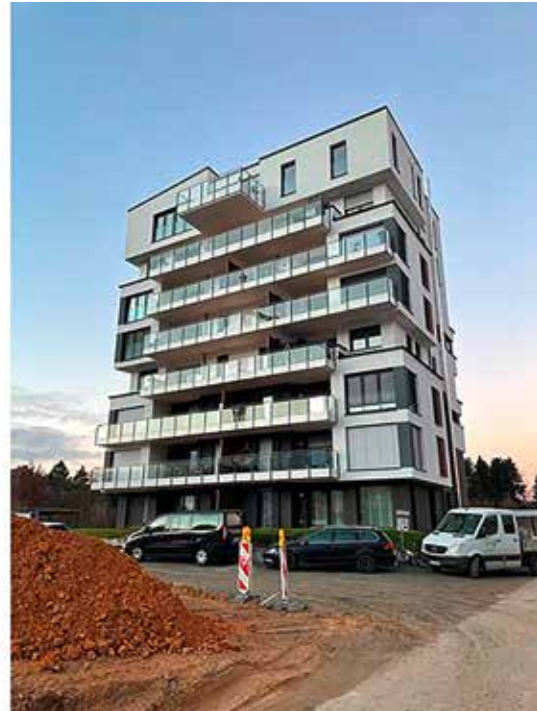
Foto Haus 1, Wesr und Süd – Stiefler + Seiler Architekten
