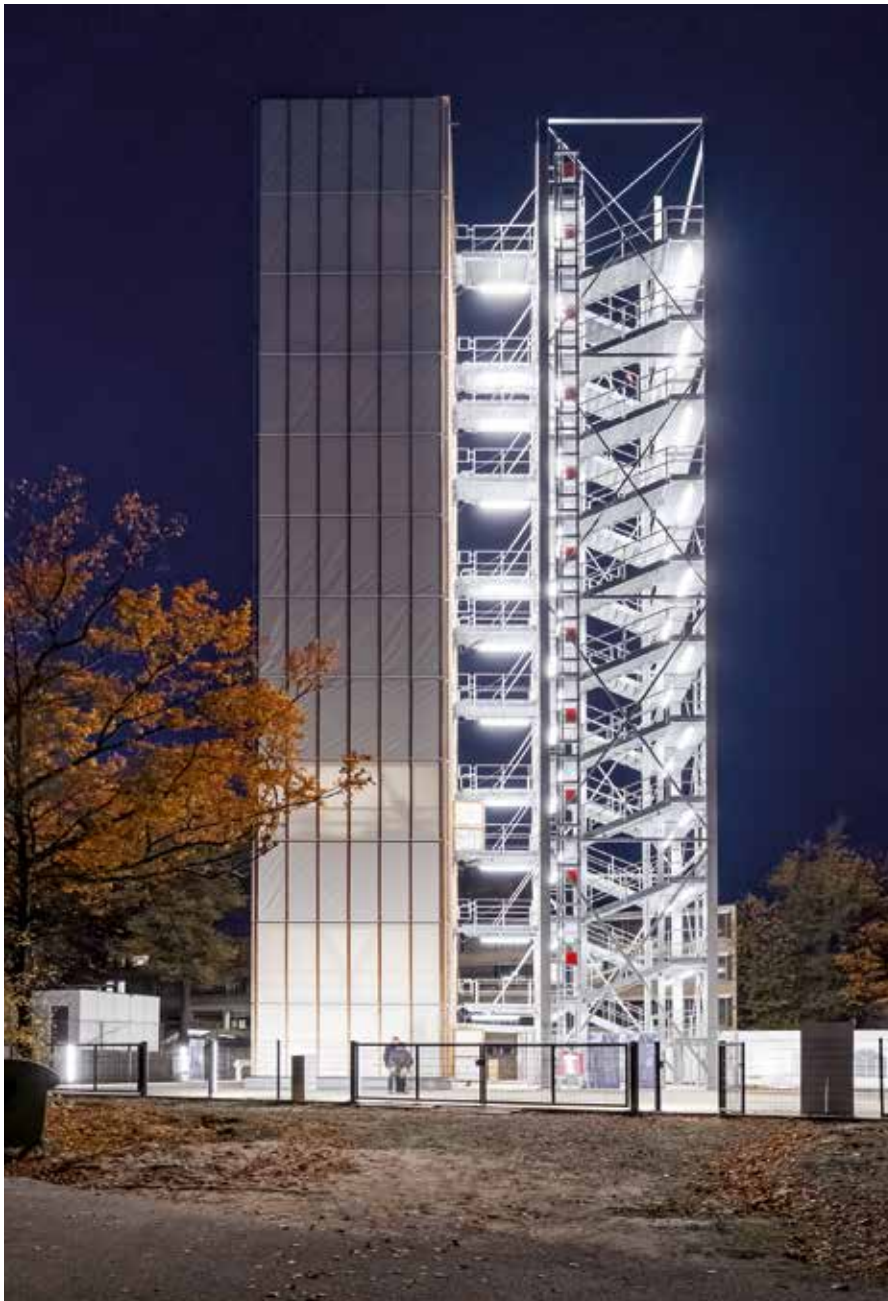
Der Demonstrator D1244 ist das erste adaptive Hochhaus der Welt – 14 Institute der Universität Stuttgart untersuchen hier im Rahmen eines Sonderforschungsbereichs, wie Planende künftig durch anpassungsfähige Tragwerke und Fassaden Materialeinsparungen von 50 % und mehr erreichen können (Quelle: René Müller, Stuttgart)
