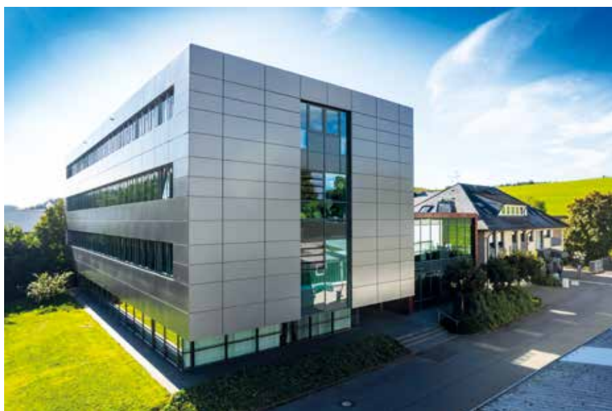
Die neue hochwertige Fassade besteht aus exakt vorgefertigten Metallkassetten, die eine Fugenbreite von nur 20 mm ermöglichen. Dadurch wirkt die Fassade elegant und modern, zeitlos schlicht.
