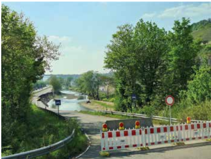
Viele Straßen sind nach der verheerenden Flut vollkommen zerstört und nicht mehr befahrbar.
