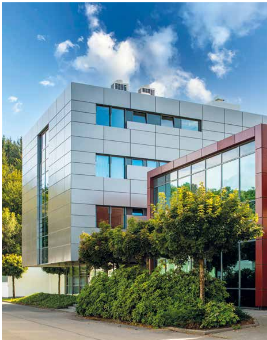
Die neue hochwertige Fassade besteht aus exakt vorgefertigten Metallkassetten, die eine Fugenbreite von nur 20 mm ermöglichen. Dadurch wirkt die Fassade elegant und modern, zeitlos schlicht.
