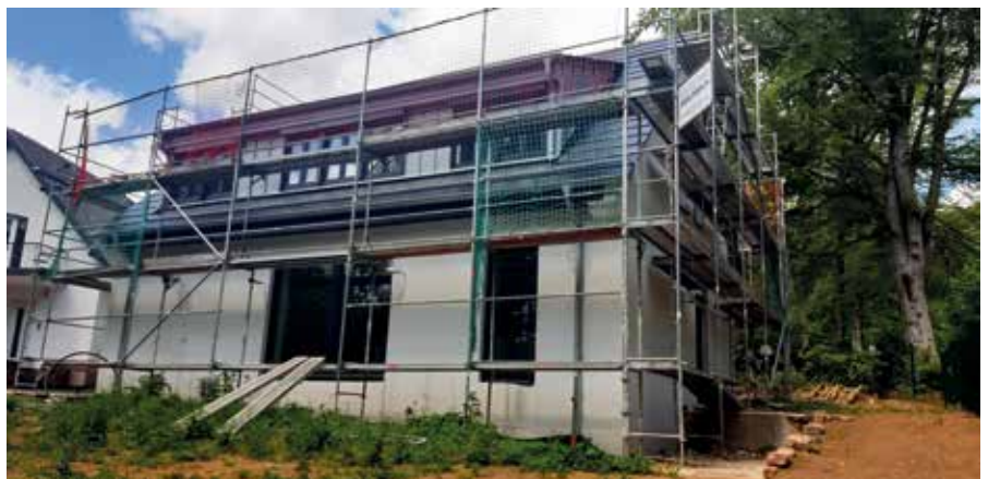
Eingerüsteter Umbau des Bestandsbaus für eine vierköpfige Familie
