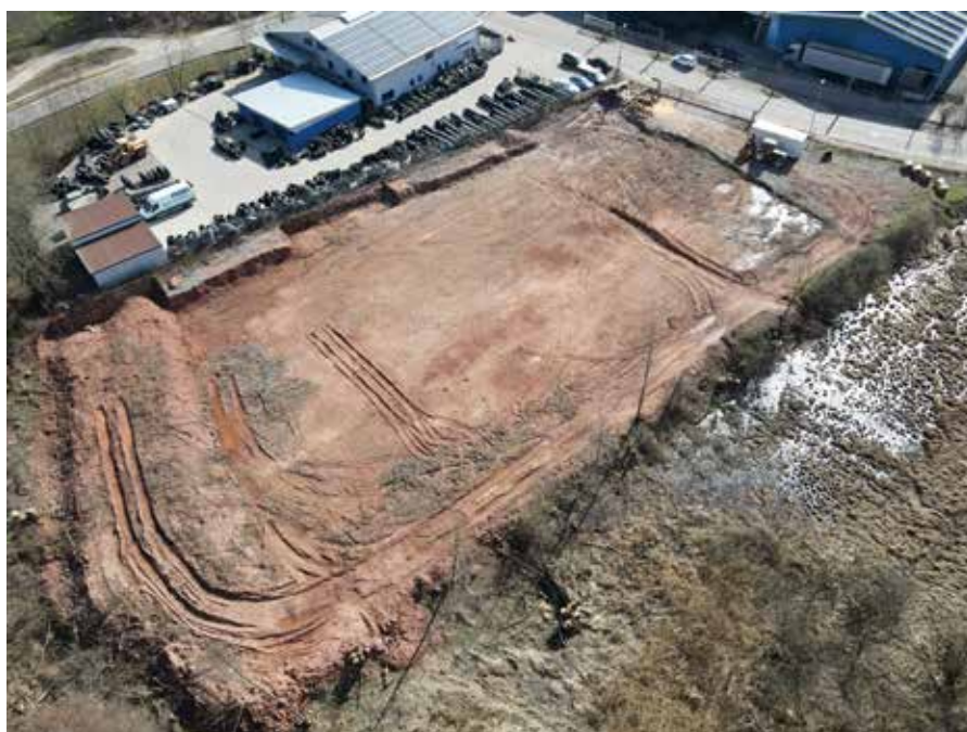
Baugelände des künftigen Forsthauses Annweiler (Bild: Trifels Natur GmbH)
