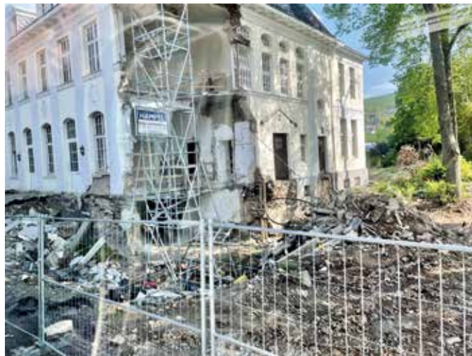
Die Flut hat eine Spur der Verwüstung hinterlassen.
