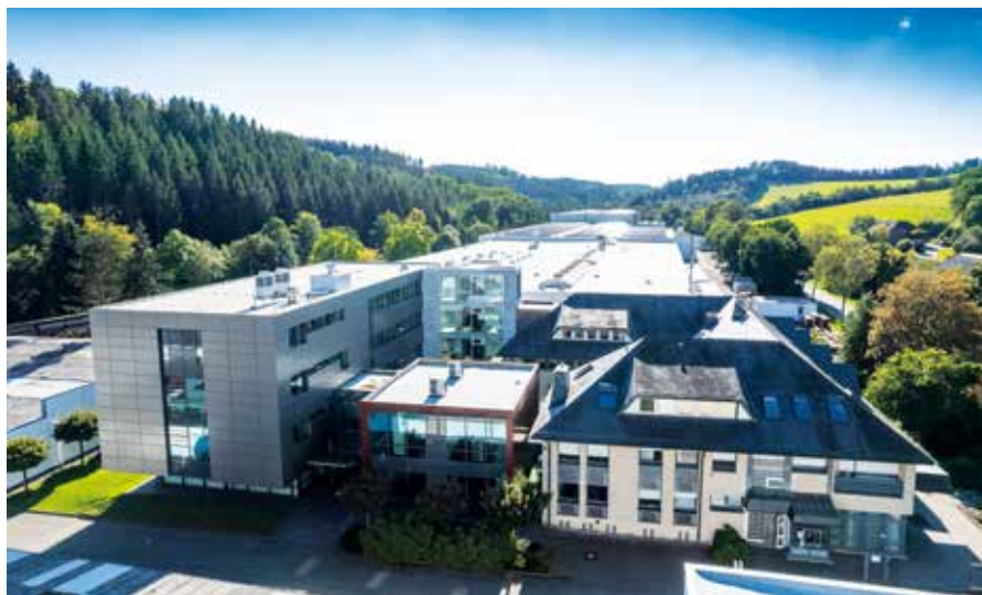
Nach der Erweiterung des Bürogebäudes in Morsbach-Lichtenberg und dem Büro-Neubau in Coswig bei Dresden, wurde nun auch das Bürogebäude am Standort Friesenhagen-Steeg erweitert. Es ist der erste Bauabschnitt innerhalb eines umfangreichen Gesamtkonzepts zum Ausbau und zur Modernisierung des Stammsitzes der ALHO-Gruppe.
