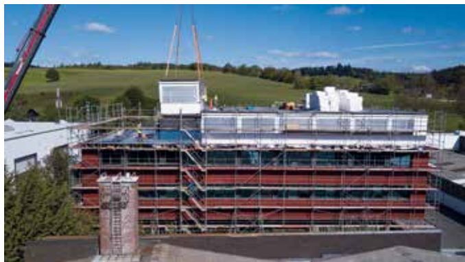
Von Freitagnachmittag bis Samstagmittag dauerte die Modulmontage. Montags konnten alle Mitarbeiterinnen und Mitarbeiter ohne Einschränkungen weiterarbeiten.
