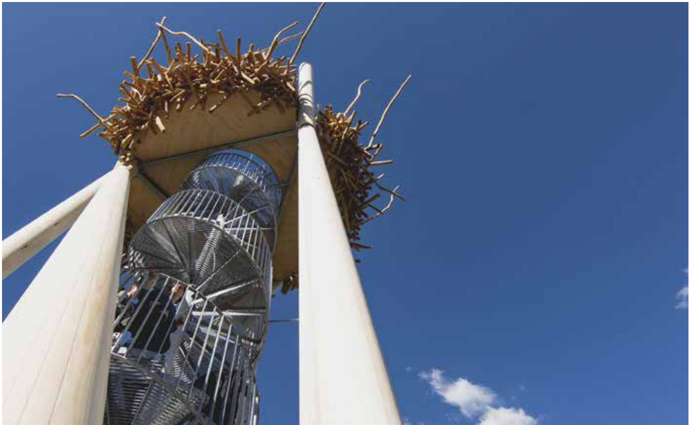
Die ringförmige Brettspertholz-Platte steift zusammen mit dem Stahlträger-Dreieck die Turmkonstruktion aus. (Bildquelle: Holzbau Baumer – Rainer Spaniel)
