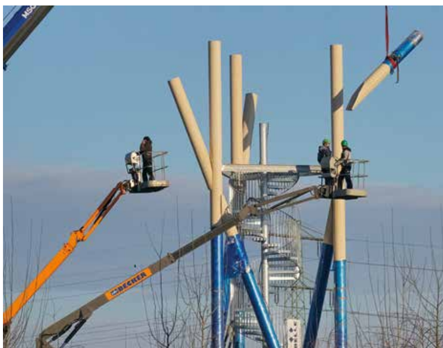
Montage eines Endstückes einer geteilten schrägen Stütze mit rund ausgefrästem Ende. (Bildquelle: Holzbau Baumer – Rainer Spaniel)
