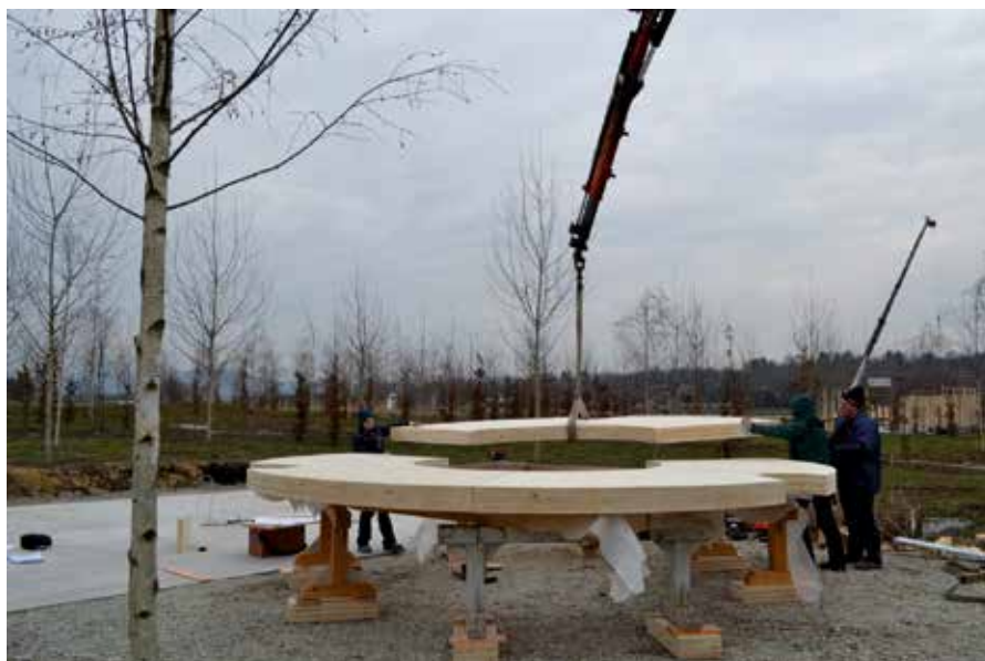
Die drei Brettsperrholz-Segmente werden vor Ort zu einem biegesteifen Ring verbunden. (Bildquelle: Holzbau Baumer)
