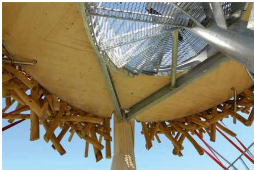
Brettsperholz-Ring und Stahlträger sind über die Flansche miteinander zu einer sich gegenseitig verstärkenden Aussteifungsebene verschraubt. (Bildquelle: Holzbau Baumer)
