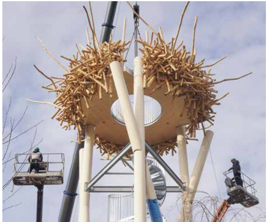
Einfädeln der Aussichtsplattform samt Nestkonstruktion an den Plattform-Einbuchtungen in die senkrechten Strebenblöcke (Bildquelle: Holzbau Baumer – Rainer Spaniel)
