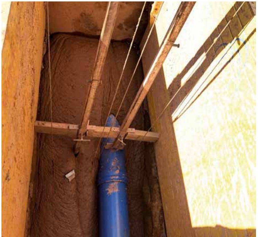
Kanalrohrverlegung in Flüssigboden
