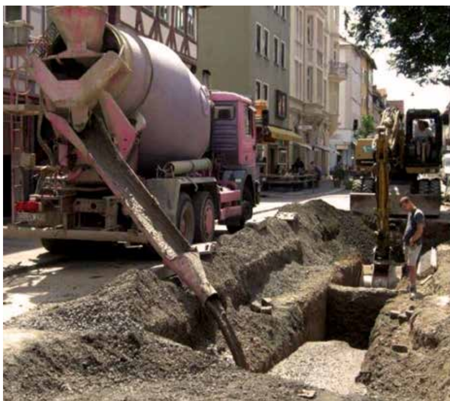
Flüssigbodeneinbau
