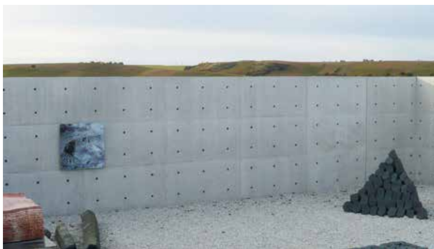
Die Arbeitsfuge im Innenhof (links vom Pyramidenkopf) fügt sich unauffällig in das Gesamtbild ein.
