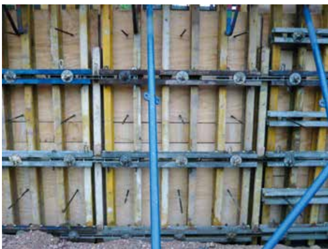
Anordnung der Schalungsanker; angespannt und lose
