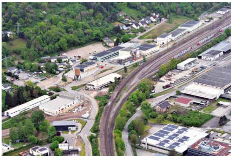
Eine Baustelle wie jede andere? Nein, der Schein trägt. Auf dem Gelände der früheren Kartonagenfabrik im Norden Triers nimmt das neue CO 2 -neutrale Energie- und Technikzentrum Gestalt an, das Ende 2022 fertiggestellt sein soll. Foto: Stadtwerke Trier / SWT
