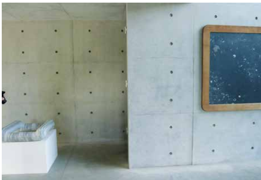
Schalungsstöße auf drei Flächen und Beibehaltung des Rastermaßes bei einem Wandversprung. Alle Fotonachweise: Beton Marketing West GmbH
