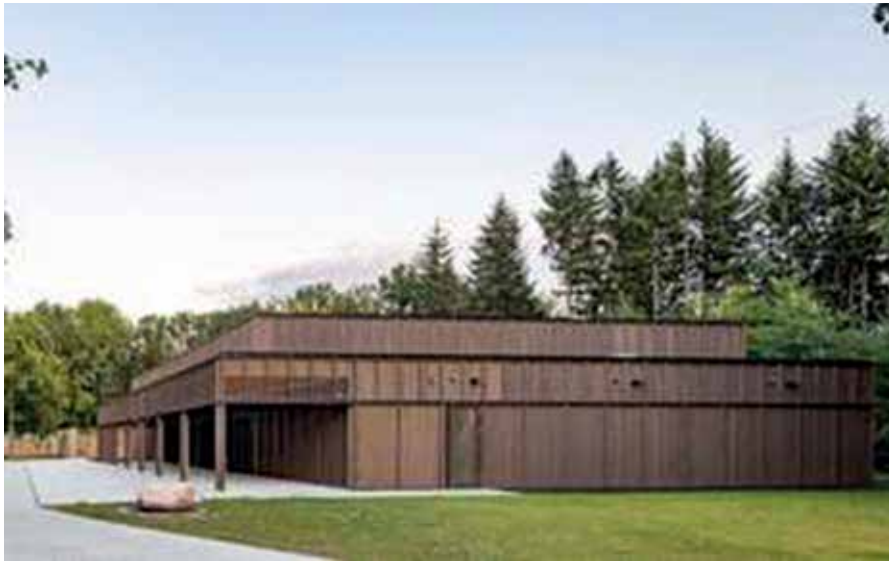
Am Übergang vom Ortsrand in den Bienwald: Die Kulturhalle von Schaidt (alle Fotos: AV1 Architekten GmbH, Kaiserslautern)
