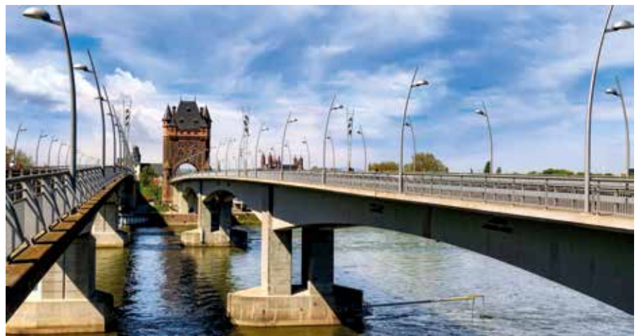
Die Nibelungenbrücke in Worms ist als erste Brücke weltweit im sogenannten Freivorbauverfahren entstanden.
