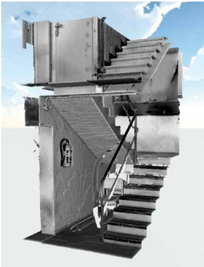
3-D Scan Bestand: Treppenhaus UG und EG
