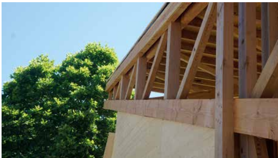
Mock-up Rheinland-Pfalz-Tag 2019, Trägerdetail
