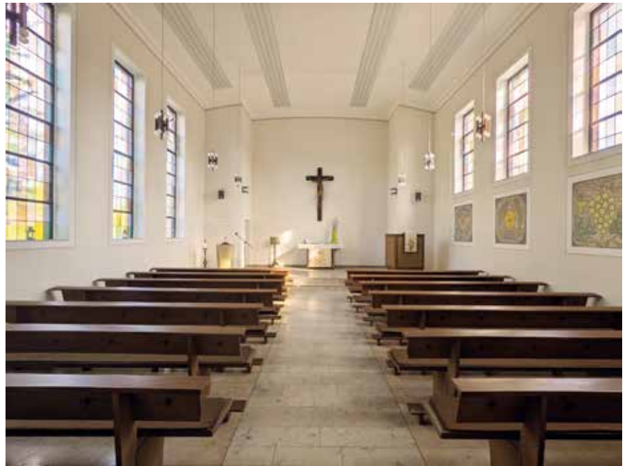
Kirchenschiff Richtung Altarraum nach Fertigstellung
