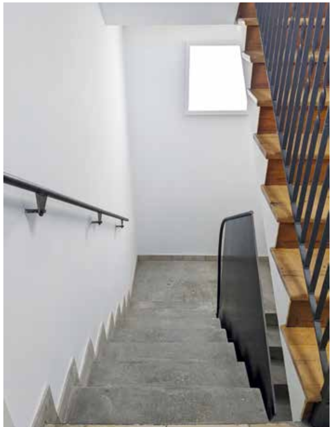
Treppenhaus Blickrichtung EG/UG
