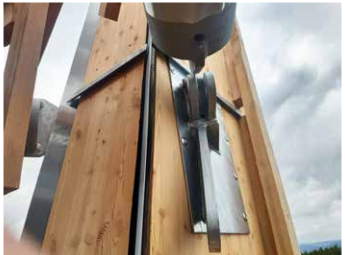
Links: Isometrie Knotenanschluss an BSH-Stütze mit Rundum-Bekleidung (Zeichnung: Ingenieurbüro Miebach) Oben: Die horizontalen Druckriegel konnten über Blechfahnen und Passbolzenverbindungen einfach und schnell angeschlossen werden. (Foto Schaffitzel Holzindustrie - Tobias Beisswenger)
