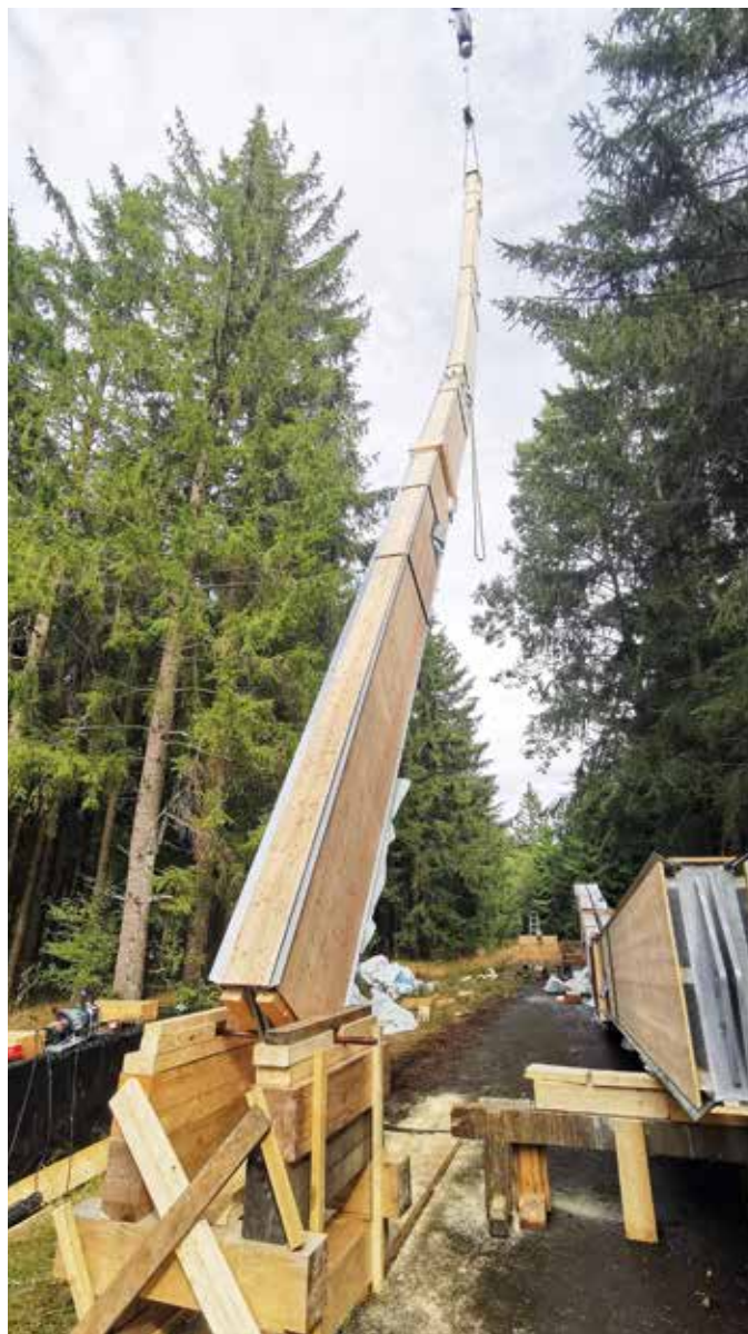
Die rund 31 m langen Stützen wurden als Ganzes vorgefertigt - inklusive des „bauteilbezogenen Holzschutzes“ in Form einer Rundum-Bekleidung - und dann auch am Stück eingehoben und montiert. (Foto: Schaffitzel Holzindustrie - Tobias Beisswenger)
