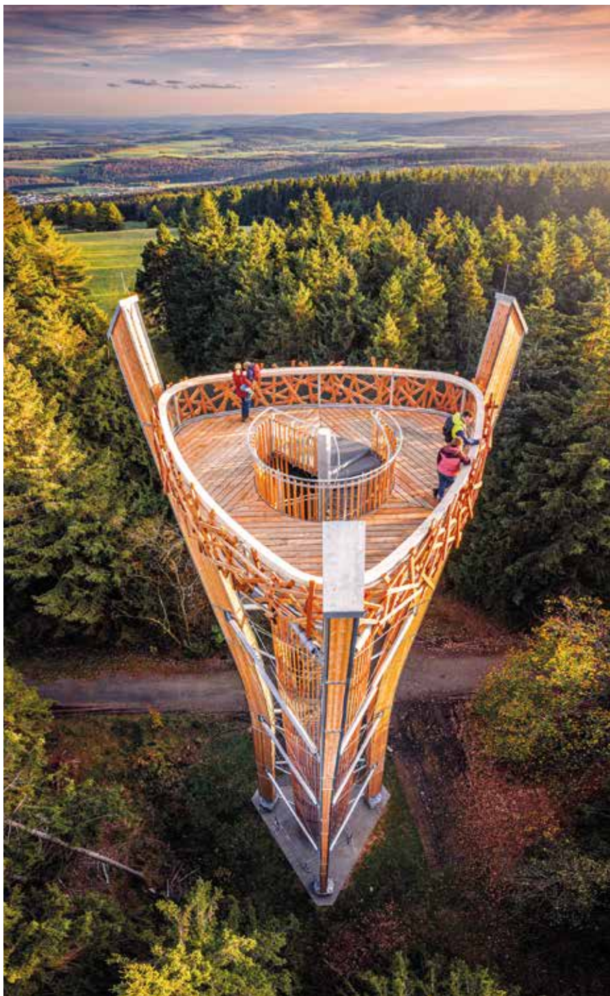
Die Aussichtsplattform des neuen Idarkopf-Turms liegt auf 28 m Höhe. Sie ruht auf den drei sich nach oben öffnenden Brettschichtholz-Stützen wie ein Vogelneest in einer Astgabel. Mit 7 m Durchmesser erreicht die Plattform eine Fläche von immerhin 27 m 2 . (Foto: EdelSteinLand - Renée Nolte - soonteam cc)
