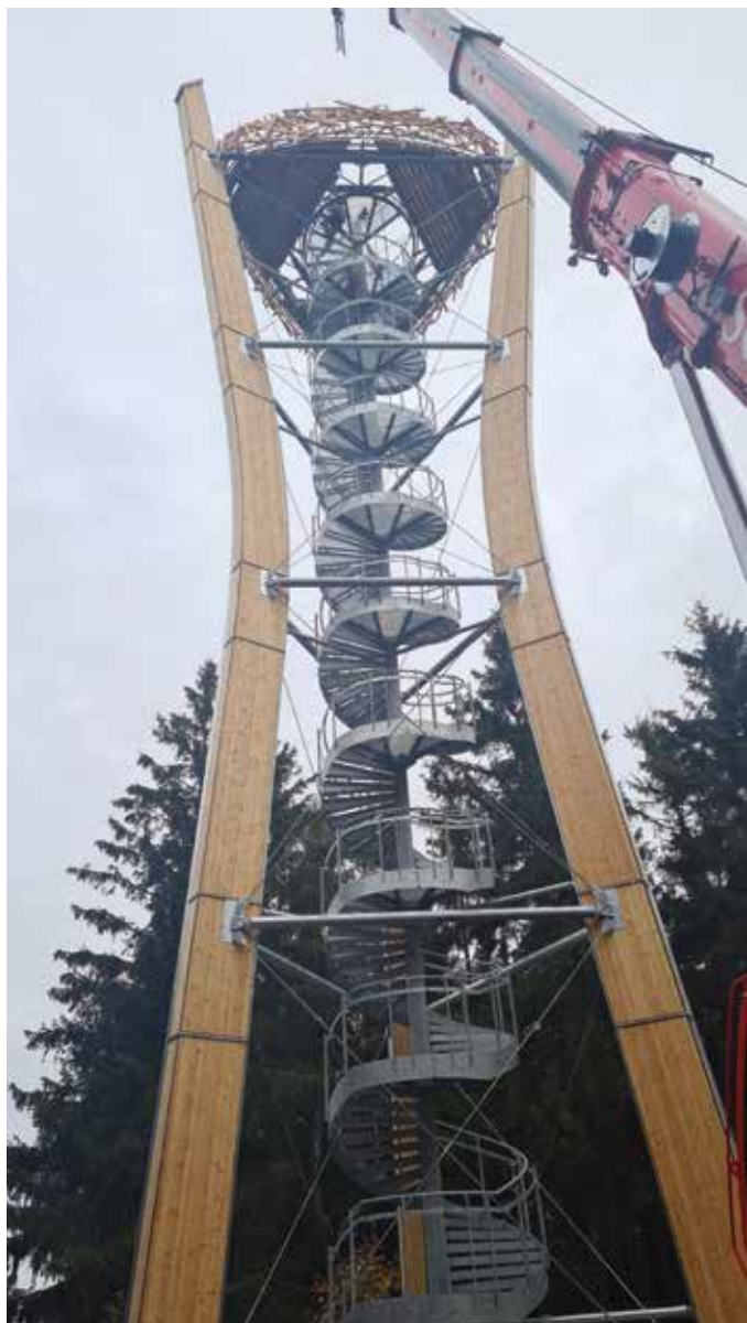
Nach der Montage des Turmtragwerks wurde die freistehende Wendeltreppe aus feuerverzinktem Stahl von oben in den Ausstieg der Plattform eingefädelt. (Foto: Schaffitzel Holzindustrie - Tobias Beisswenger)
