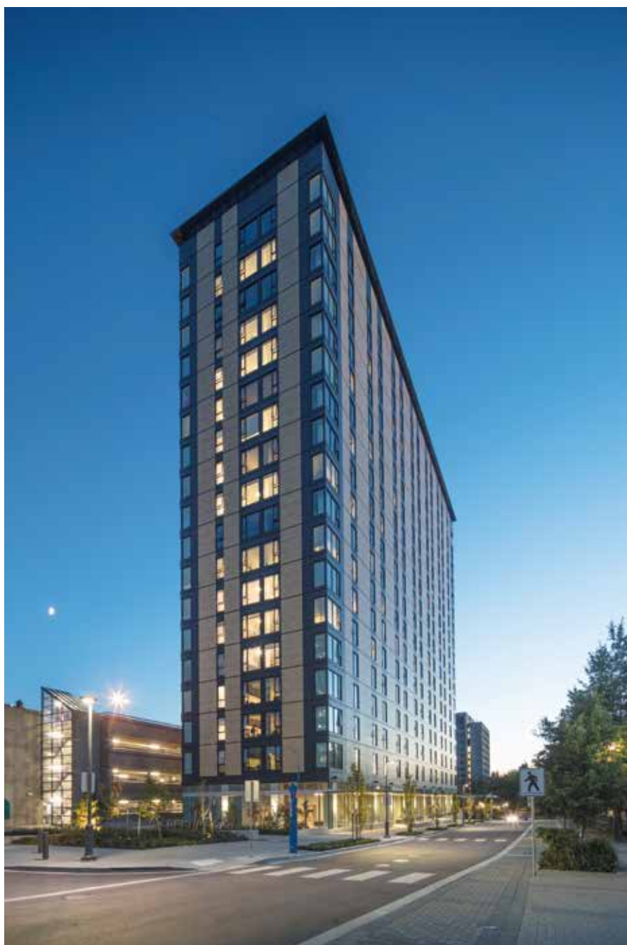
Studierendenwohnheim Brock Commons in Vancouver, seinerzeit das höchste Holzgebäude der Welt. Foto: © Michael Elkan 2017
