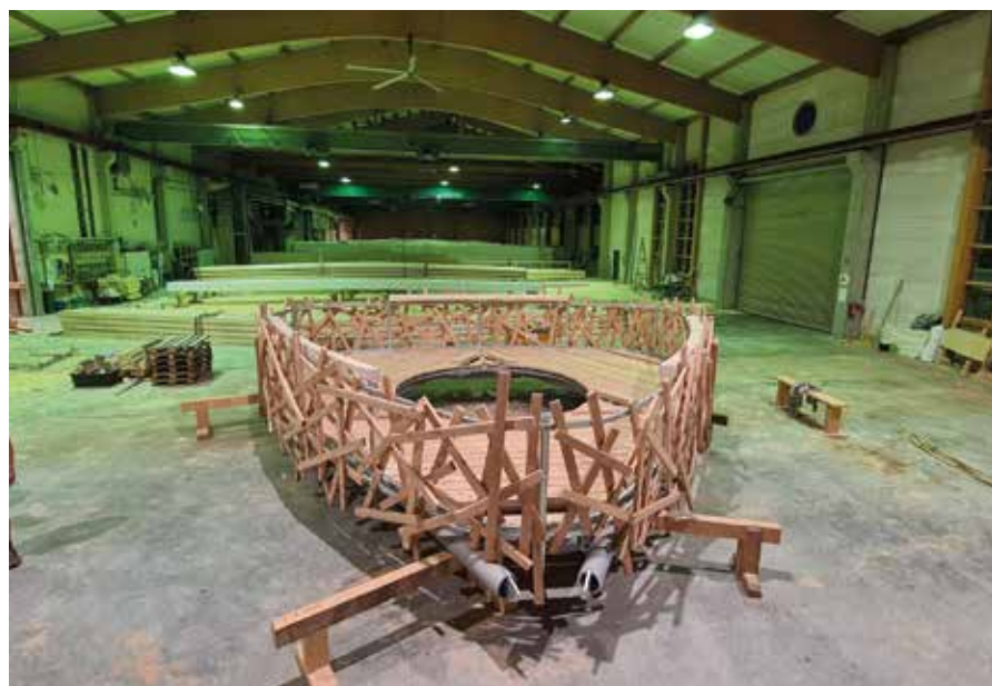
Die Vorfertigung der Nestkonstruktion erfolgte ebenfalls im Werk. Die drei Lagen scheinbar unregelmäßig verteilten Lärchenholz-Stäbe folgen einem System, das im 3D-CAD regelrecht geplant wurde. (Foto: Schaffitzel Holzindustrie)
