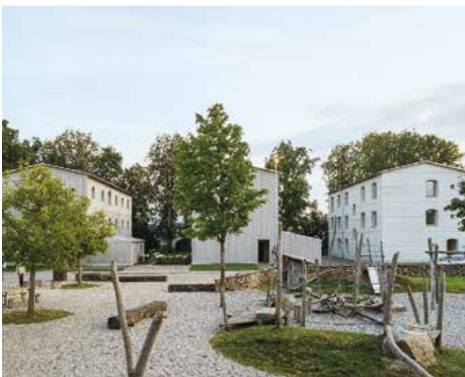
Die Forschungshäuser in Bad Aibling, für viele ein Sinnbild für „einfaches Bauen“. Foto: Sebastian Schels
