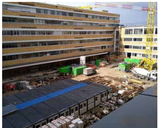
Sicht auf die Baustelle in einer der Zwischenflächen von den alten Gebäuden. Jetzt Containerstellplatz und Lager für die Baustelle
