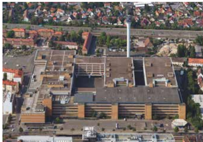
Luftbild vom Gesamtareal Versandhaus Quelle 2019. Im Hintergrund der Kamin vom Heizkraftwerk mit dem Quelle Logo.
