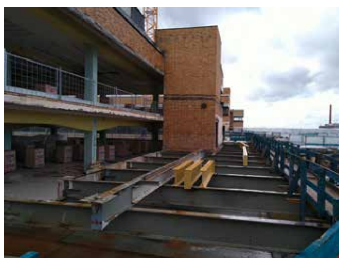
Blick auf die Hilfst tragkonstruktionen aus Stahlrahmen
