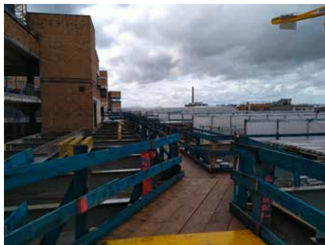
Blick auf die Hilfst tragkonstruktionen aus Stahlrahmen
