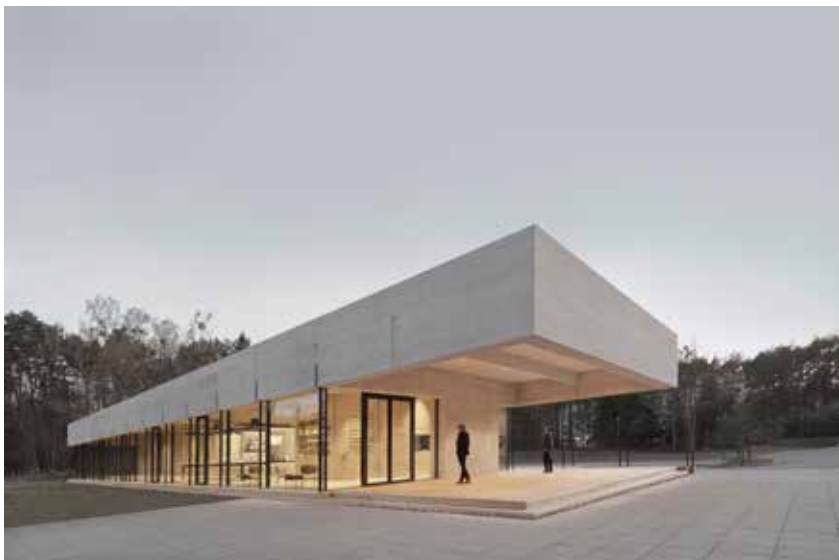
Auffallendes Merkmal des neuen Besucherzentrums ist das weit auskragende Dach, dessen Umrandung aus Liapor-Leichtbeton besteht. Foto: Brigida González
