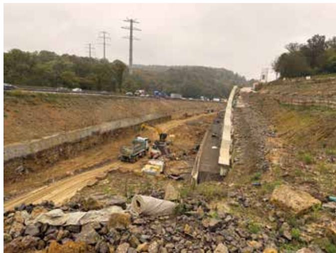
Baustelle A8 Pforzheim
