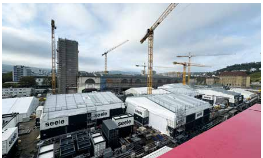
Oberirdische "Baustelleneinrichtung" von Stuttgart 21
