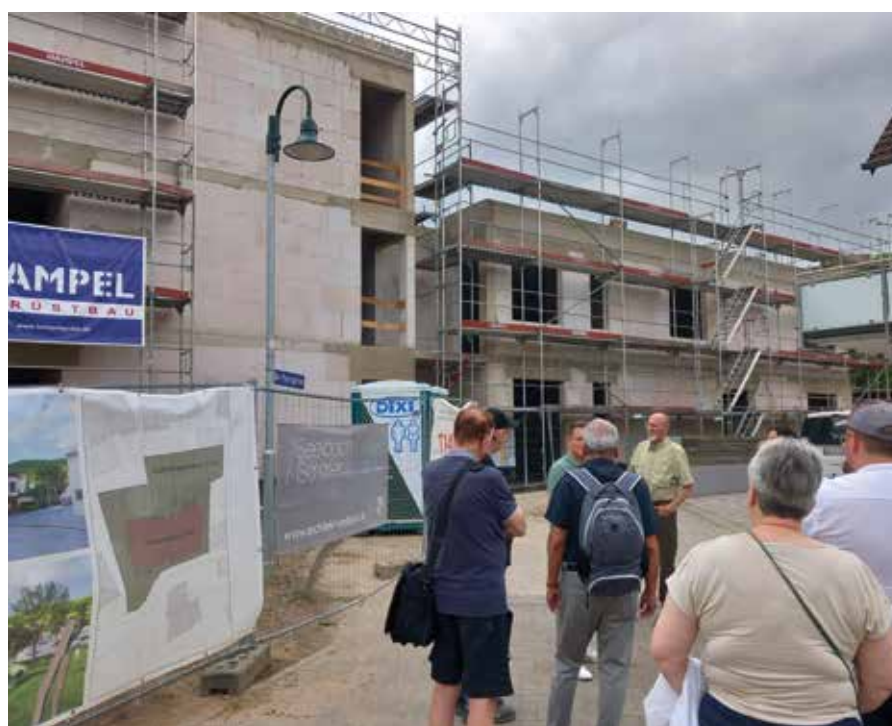
Rohbau des neuen Kindergartens in Dernau
