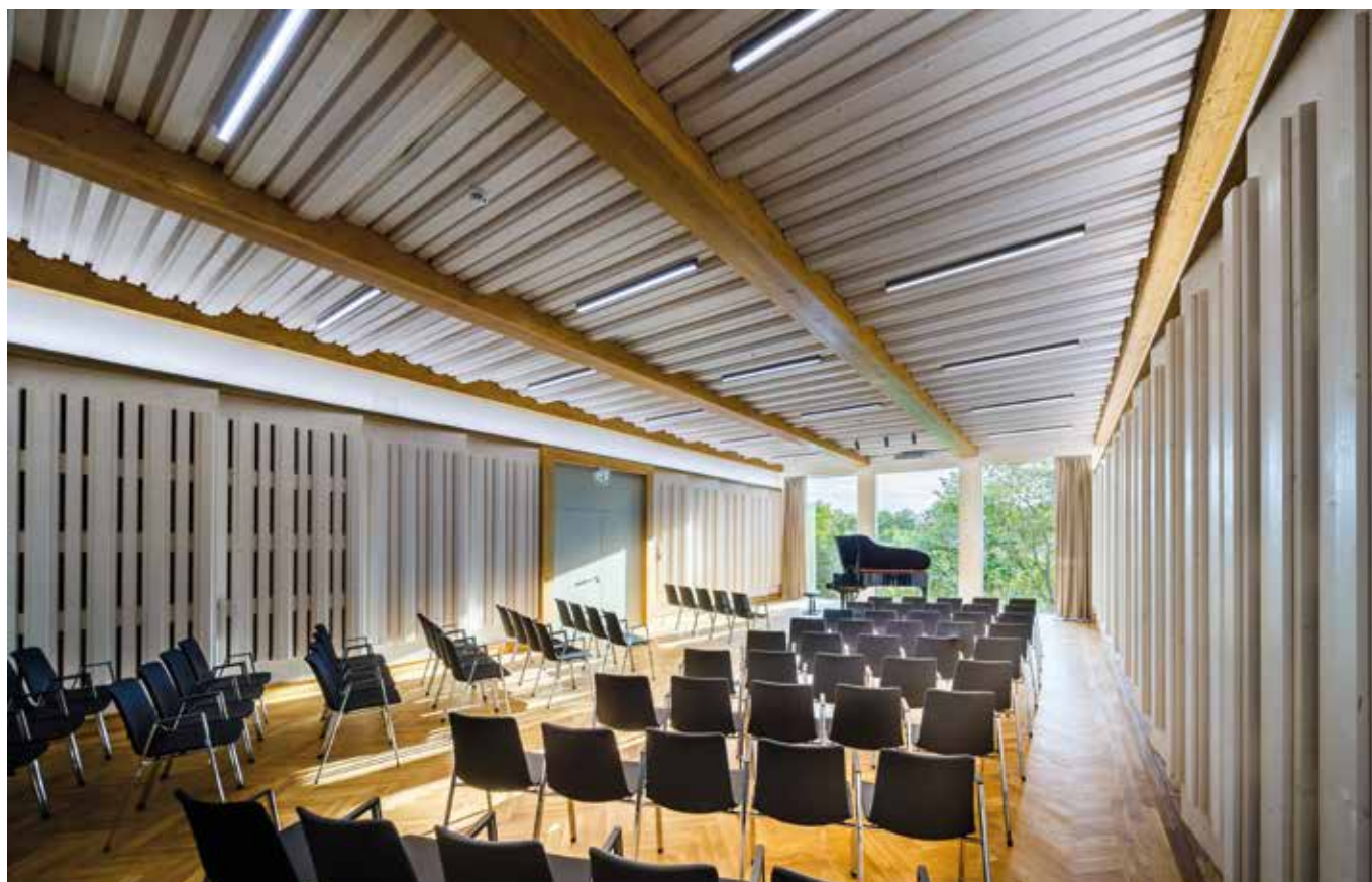
Der 120 m 2 große Kammermusiksaal der Mainzer Akademie der Wissenschaften und der Literatur setzt auf einen bestehenden Gebäudetrakt auf und bietet rund 80 Personen Platz. Speziell konzipierte Wand- und Deckenpaneele verwandeln den Holzbau in einen optimalen Resonanz- und Klangkörper. Foto: Jochen Veith
