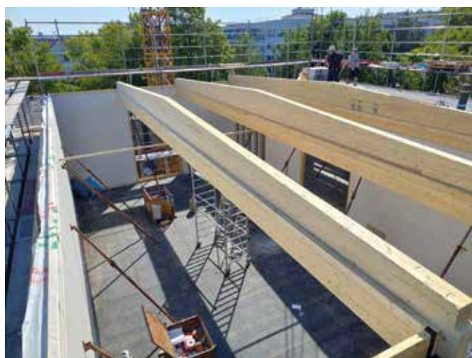
Drei Brettschichtholz-Satteldachbinder bilden das Dachtragwerk – davon zwei in den Drittelpunkten der Saalbreite und einer in Trennwandebene. Foto: Ochs GmbH
