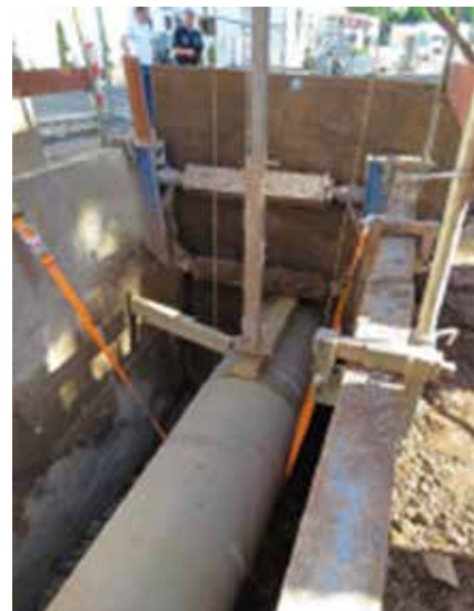
Verlegung der großen Rohrquerschnitte
