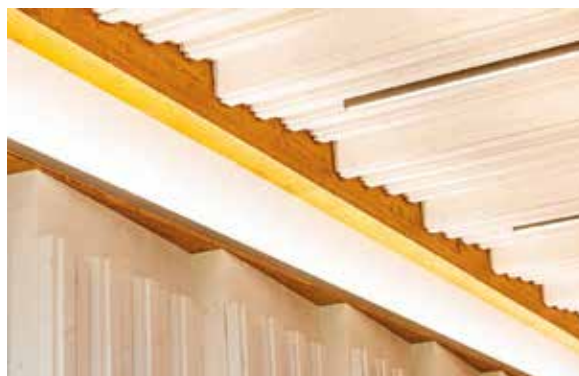
An bestimmten Stellen gelochte Holzoberflächen fungieren als Lochplattenresonatoren.
