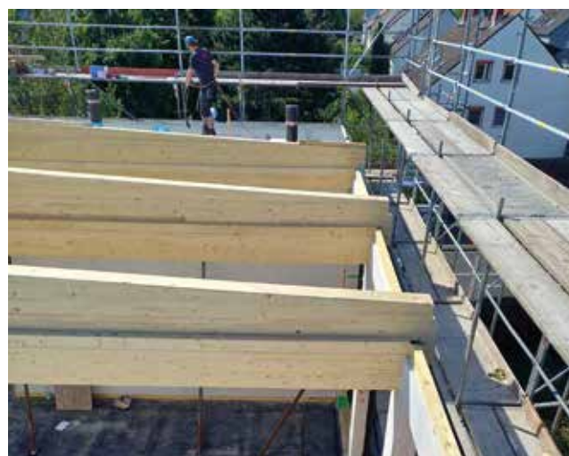
Als Auflager für die unterseitig ausgeklinkten Satteldachbinder dienen Brettschichtholz-Stützen, die in den Außenwänden integriert sind. Foto: Ochs GmbH
