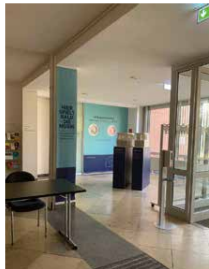
Um das Bestandsgebäude umbauen, aber Teile davon bzw. angrenzende oder vom Umbau mitbetroffene Räume partiell weiternutzen zu können, wurde eine Staubschutzwand (hinten in hellblau) eingezogen. Foto: mamuth / Timm Helbach
