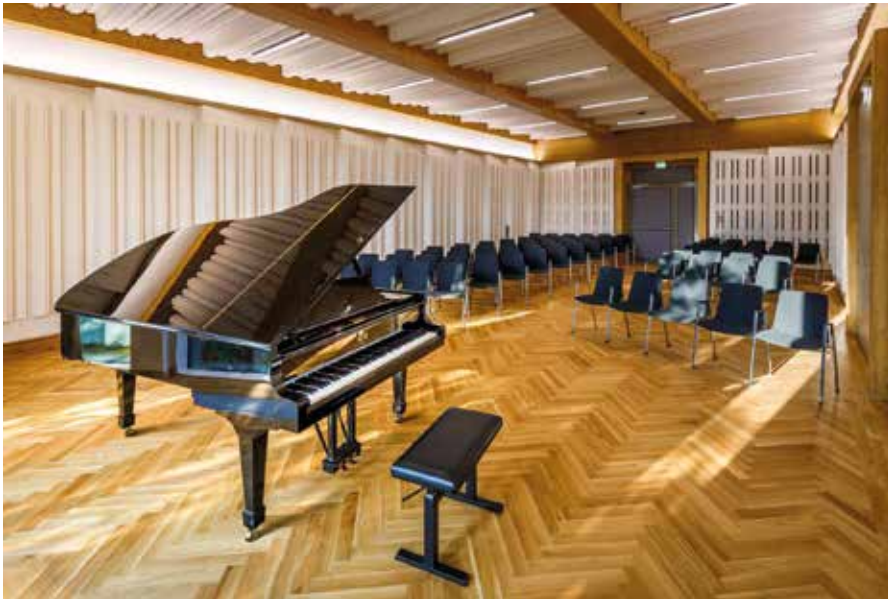
Die speziell entwickelten Paneele für Decke und Wand ermöglichen die Feinjustierung der Raumakustik. Auch die Saalrückwand des Musiksaals inklusive der Doppeltür ist so bekleidet, dass sie entsprechende Resonanzen absorbieren kann.
