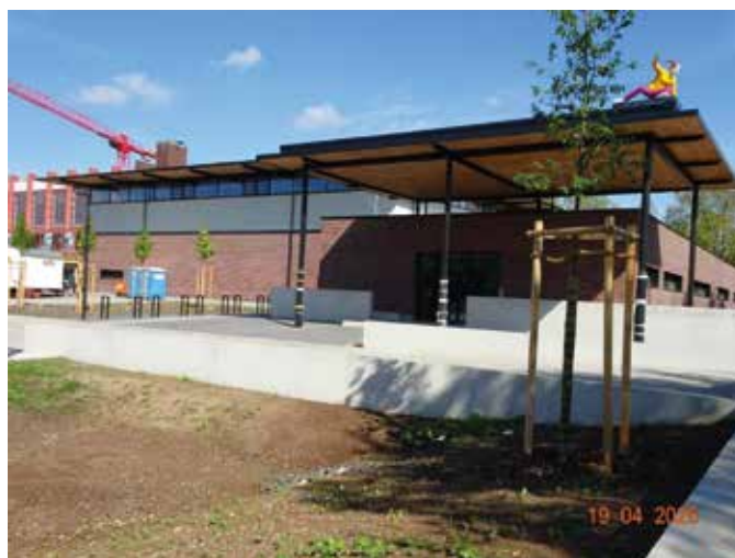
Blick über die Rigole zum Eingangsdach
