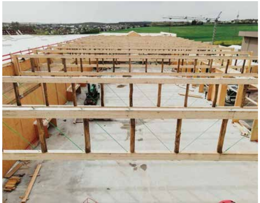
Montagezustand © CLTECH GmbH
