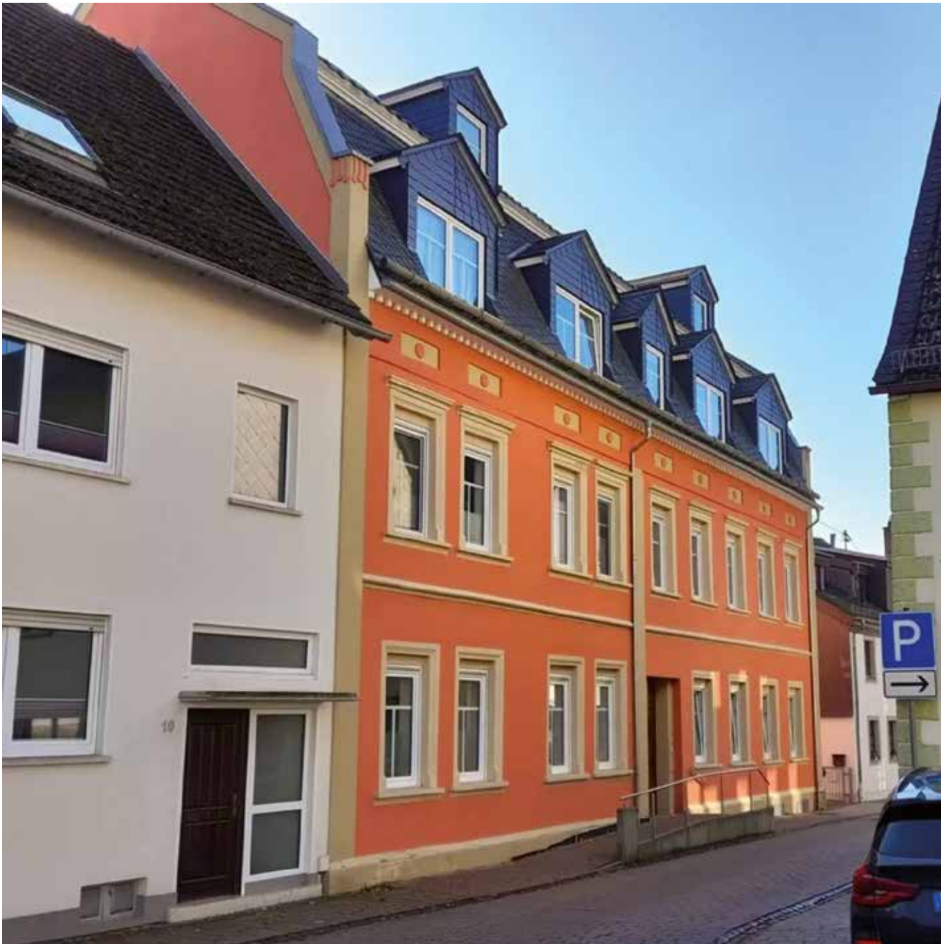
Haus Meletta - architektonisches Schmuckstück - nach der Kernsanierung
