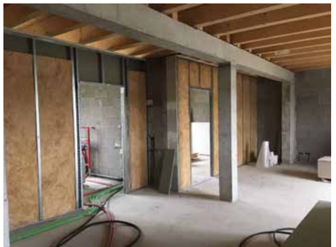
Kernsanierung - Einbau neuer massiver Bauteile
