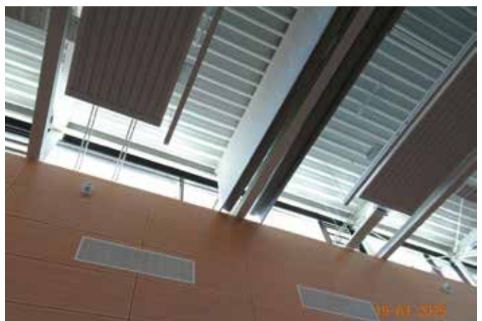
Deckenstrahlungsheizung + Trennvorhänge
