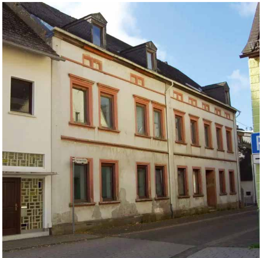
Haus Meletta im Dornröschenschlaf vor der Kernsanierung
