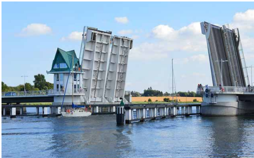
Die Schleibrücke in Kappeln, eine zweiflügelige Doppel-Klappbrücke.
