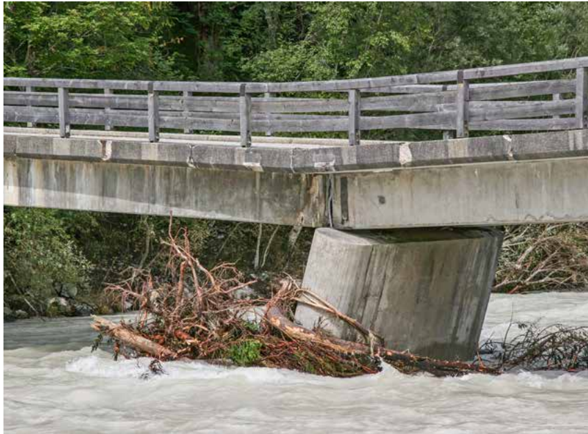
Treibgutablagerung an einer Brücke - Verkläuserung
