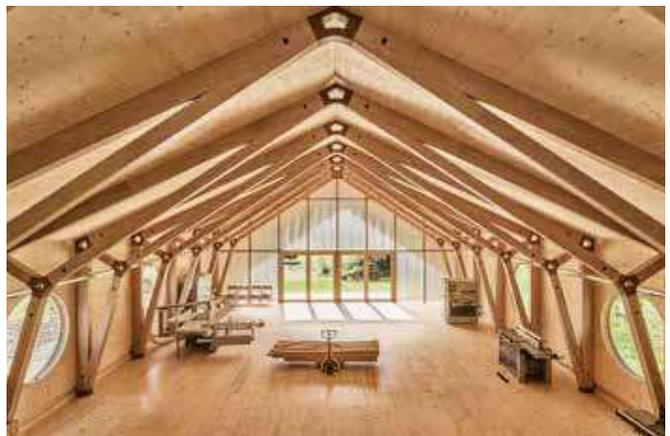
Abbildung 5: Werk- und Forschungshalle Diemerstein. Bauwerk zu 100% reversibel. Innenansicht. Quelle: t-lab / Andreas Labes, Berlin
