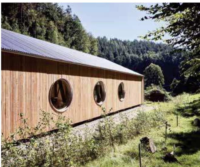
Abbildung 6: Werk- und Forschungshalle Diemerstein. Douglasienfassade als Vorhangfassade. Außenansicht. Quelle: t-lab / Andreas Labes, Berlin
