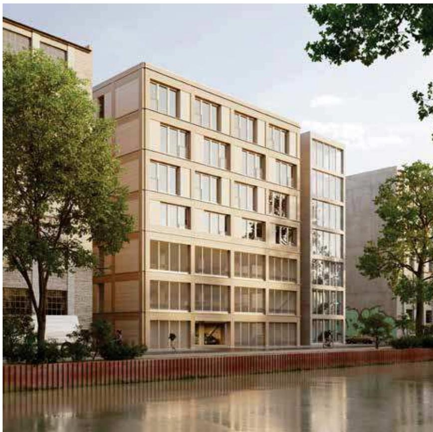
Abbildung 1: „Wandelbarer Holzhybrid“. 7-geschossiges Gebäude bis zur Hochhausgrenze für die Nutzungen Parken (3 Geschosse), Arbeiten (1 Geschoss) und Wohnen (3 Geschosse) nach [5]. Quelle: t-lab / Nicolai Becker, Stuttgart
