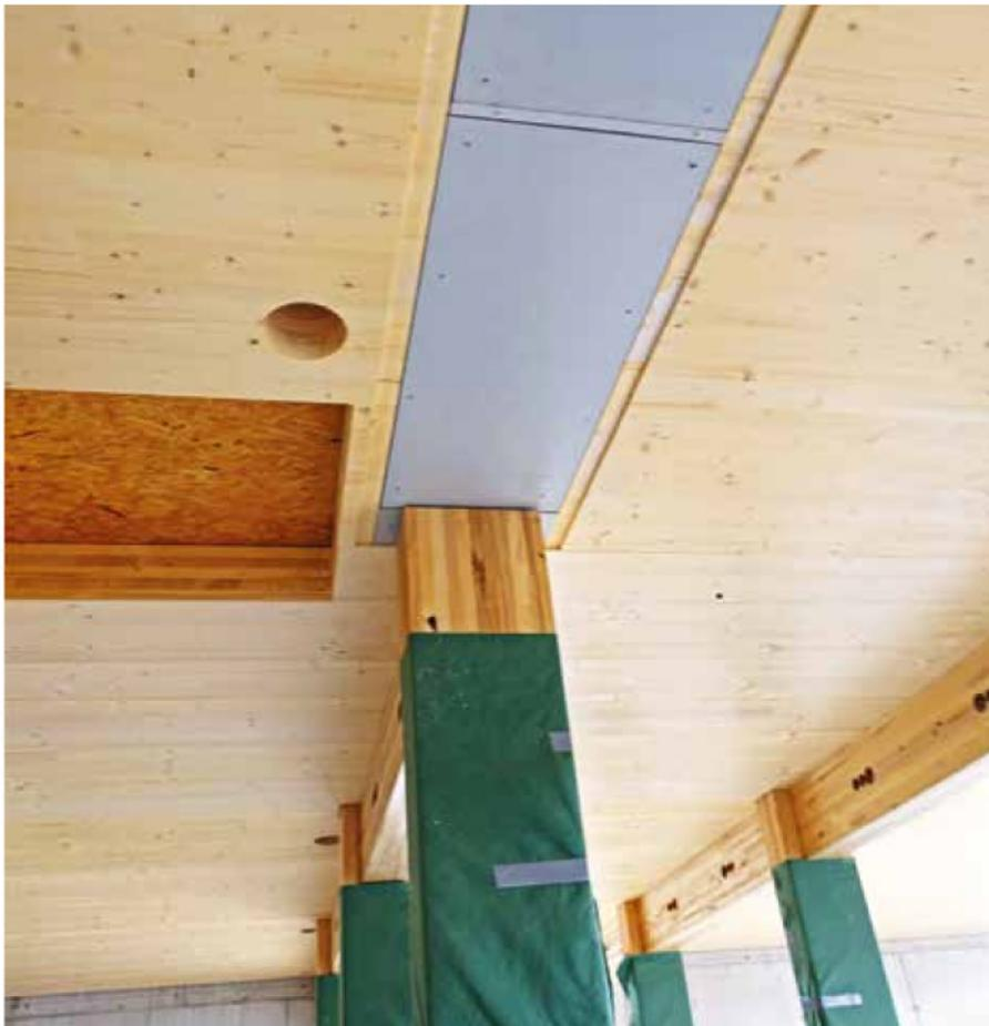
*Brandschutz im Holzbau: An der Unterseite deckengleicher Stahlträgern sind Brandschutzplatten angebracht. Zur Wahrung der Holzoptik wird noch ein Abdeckbrett ergänzt. Foto: Fast + Epp*
