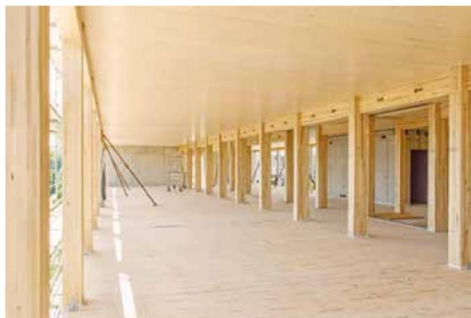
Brettspertholz-Deckenelemente, Unterzüge und Pendelstützen, die in den Flurachsen als Gabelstützen ausgebildet sind
