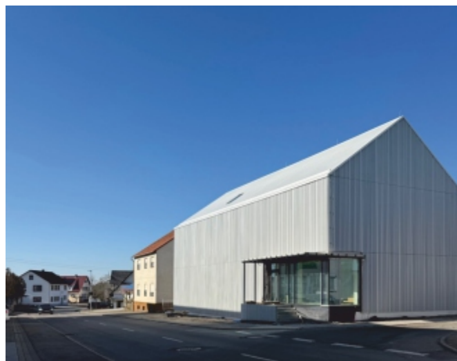
Im Bau - Bild: PARTNER-AG-SCHAKOversity
