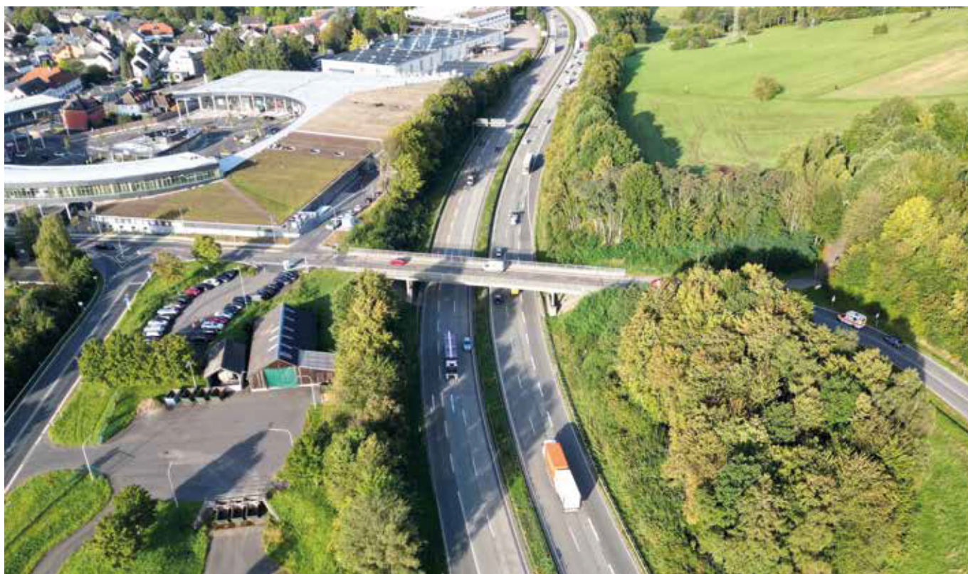
Quelle: Autobahn GmbH | Überführung der L307 über die A48
