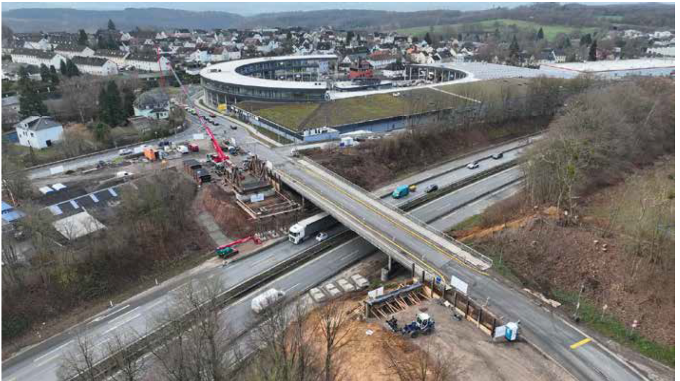
Quelle alle Fotos auf dieser Seite: Autobahn GmbH | Überführung der L307 über die A48
