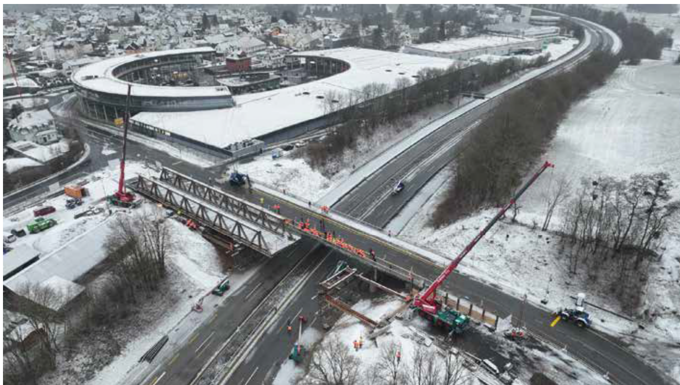
Quelle: Autobahn GmbH | Vershub der Behelfsbrücke
