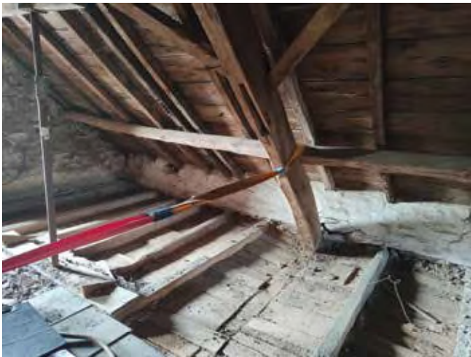
Vorgefundene Decke (Bindeuntergurt) über dem Dachraum
