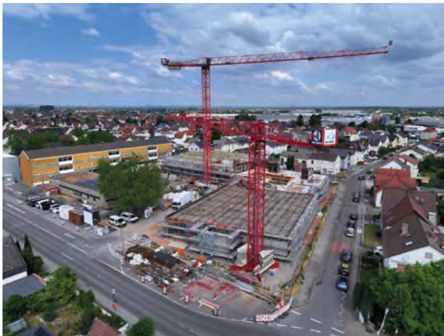
Rohbauarbeiten Schillerschule Bürstadt
