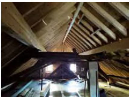
Neue Dachkonstruktion über den bestehenden Binderkonstruktionen (lastfrei)
