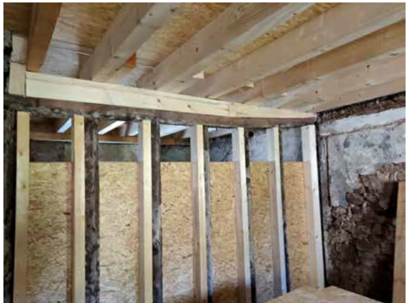
Neue Holzbalkendecke über Erdgeschoss mit Ausgleich der bestehenden Fachwerk-Innenwände
