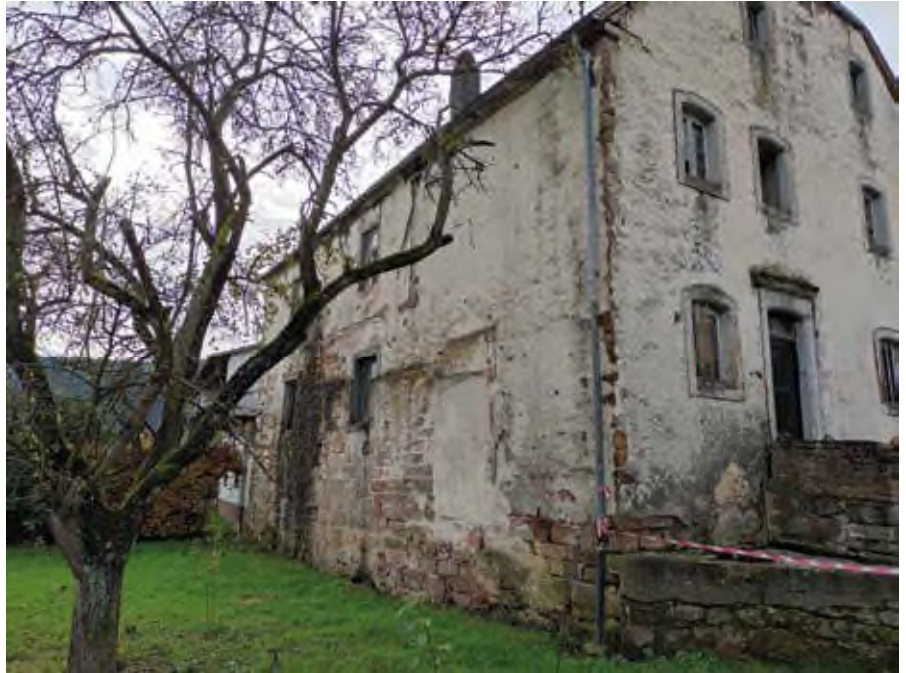
Außenansicht Bestandsgebäude vor der Baumaßnahme
