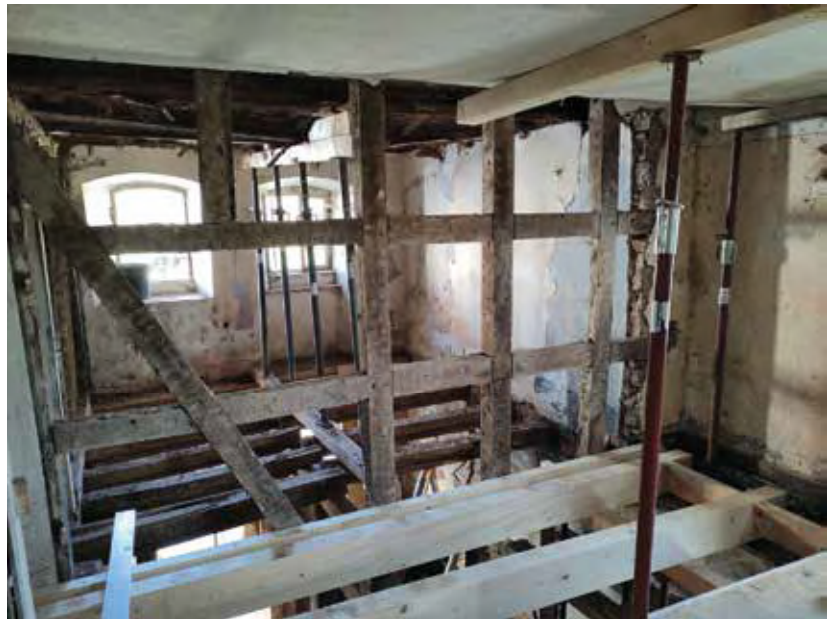
Neue Holzbalkendecke über Erdgeschoss
