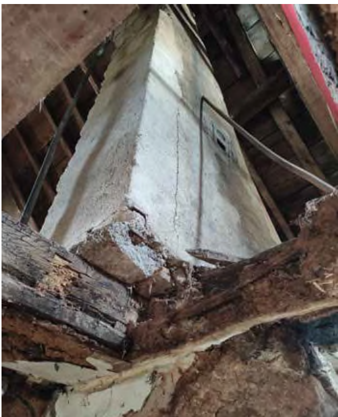
Sicherungsmaßnahmen durch den Zimmermann
