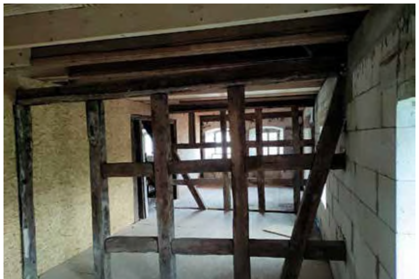
Neue Holzbalkendecke über Obergeschoss mit sichtbarem Fachwerk
