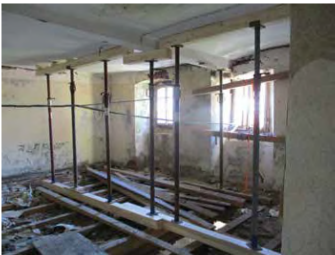
Sicherungsmaßnahmen durch den Zimmermann
