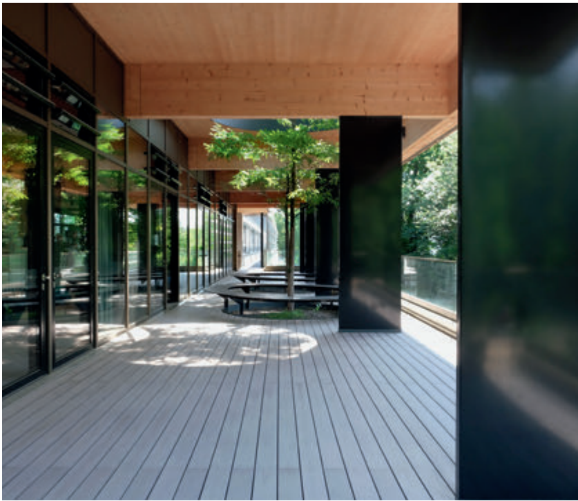
Terrasse einer Bibliothek des Gymnasiums Neubiberg, Architektur: Peck.Daam Architekten. Ausgezeichnet mit: ÜBER OBER BAYERN, BDA Regionalpreis Anerkennung. Bauherr: Zweckverband Staatliche weiterführende Schulen im Südosten des Landkreises München. Foto: Mydeck
