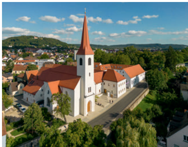
Christuskirche ©Architektur: Brückner & Brückner Architekten, Tirschenreuth | Würzburg
