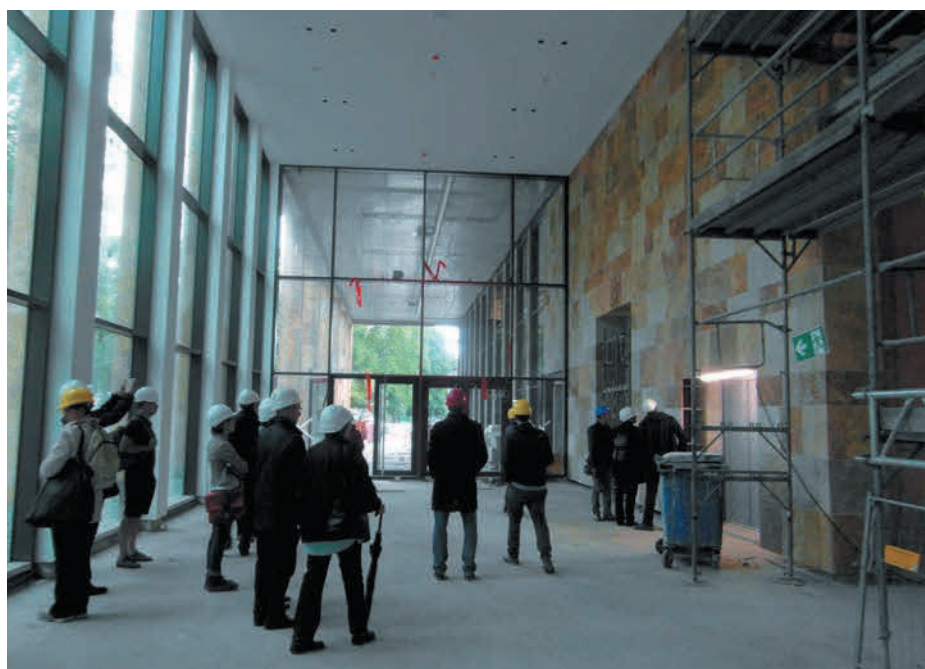
Tageslichtdurchflutetes Foyer der Halle 2 mit Öffnung zum Grünraum.
