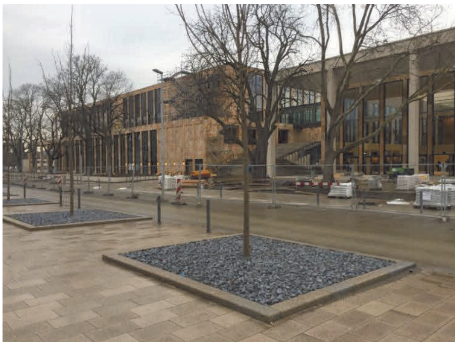
Modern und innovativ. Das neue RMCC Wiesbaden mit Haupteingang (rechts), öffentlicher Durchwegung (Mitte) und Halle Süd (links) © Esref Yavuz
