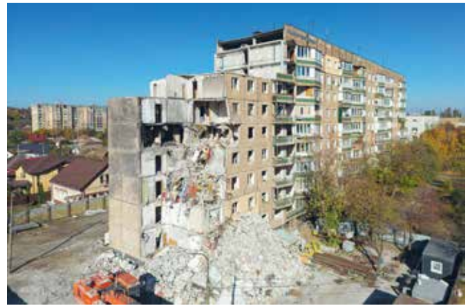
Zerstörte Plattenbauten © Philipp Meuser
